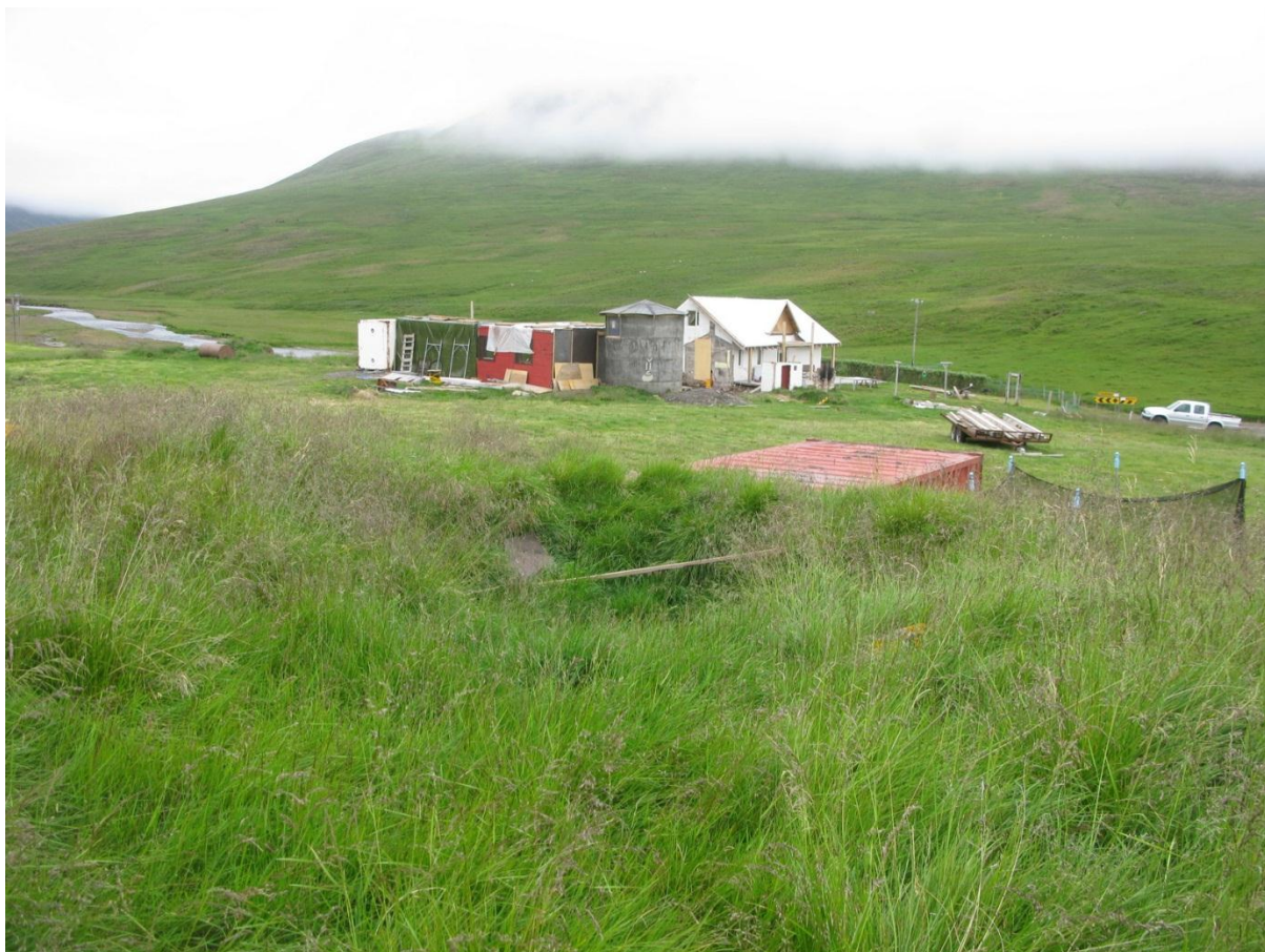
Mynd 1. Skrapatunga. Framkvæmdir standa yfir, m.a. viðgerðir á íbúðarhúsinu. Horft er til suðausturs.
