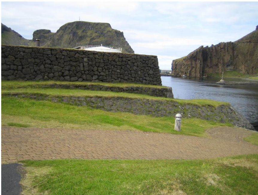
Mynd 3. Horft til norðvestur að austurhlíð virkisvegsins, eldri hleðslur í brekkunni að veggnum. Stígurinn þar sem stengurinn mun liggja er þvert yfir myndina.
