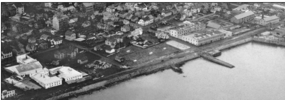
Mynd 7. Loftmynd af svæðinu, horft í vestur, árið 1930. Sjóvarnargarður er með allri Skúlagötunni, en líklega hefur grjótið úr bryggjunum sem voru þar við ströndina verið sett í garðinn. Hluti af Kveldúlfsbryggjunni stendur þó enn. 22
