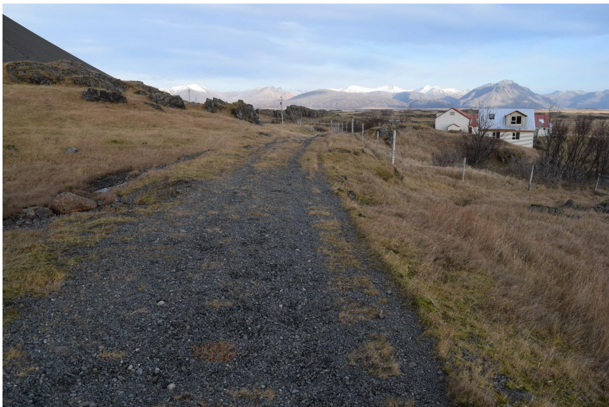
Vegur 015- Horft til austurs að Stafafellsfjöllum
