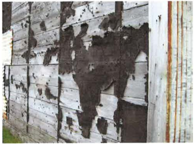
Horft eftir vesturhlið hússins.
