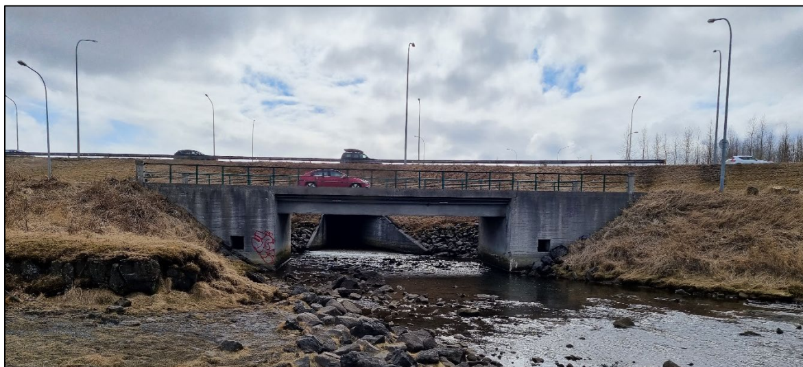
Mynd 29. Brúin yfir vestari kvísl Elliðaánna frá 1941 árið 2021, horft í suður.
