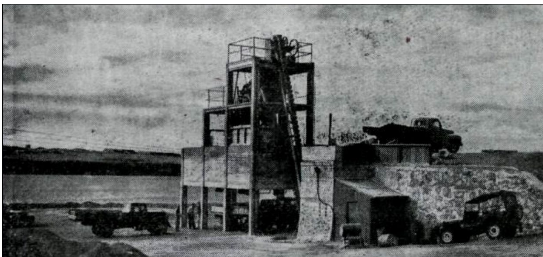
Mynd 17. Grjótmulningsvél við grjótnám bæjarins í Ártúnshöfða árið 1945. 41
