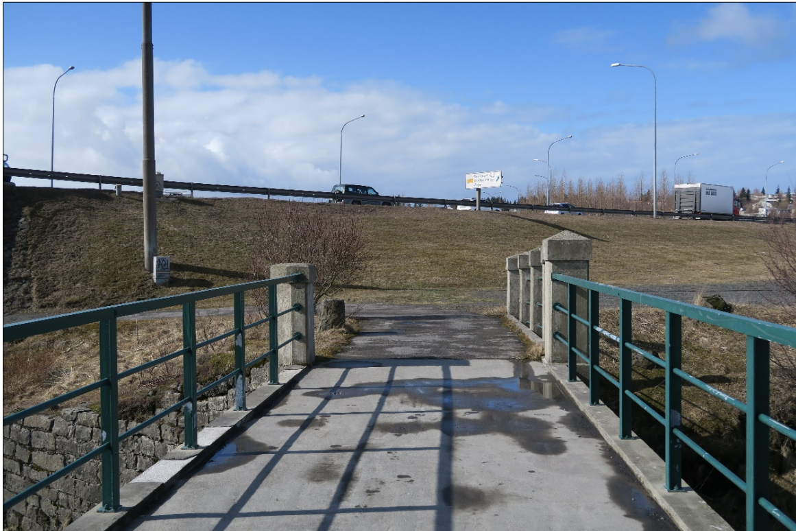
Mynd 27. Gamla brúin yfir eystri ána endurgerð, horft til suðvesturs.
