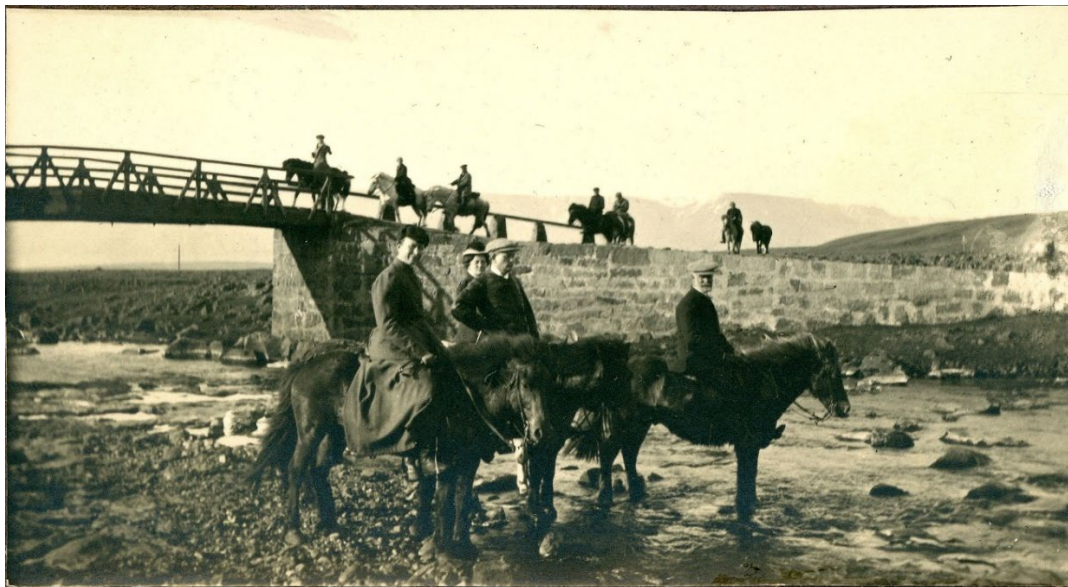
Mynd 8. Gamla Elliðaárbrúin (323-22) yfir eystri kvíslina, sem var byggð 1883. 25
