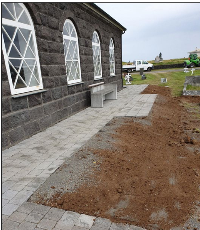
Mynd 4. Eftir að búið er að ganga frá svæðinu ný stétt. Ljósmynd frá Beimi.
