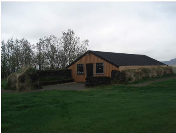
Hús sem byggt var á grunni lambhúss 072, horft til austurs.
