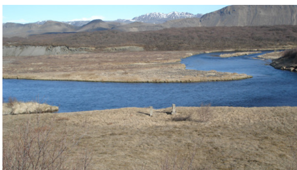
Steyptir hliðstöplar við Ölduvað 038, horft til suðausturs.
