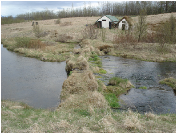
Brú 029 yfir Klofalæk, horft til suðausturs.
