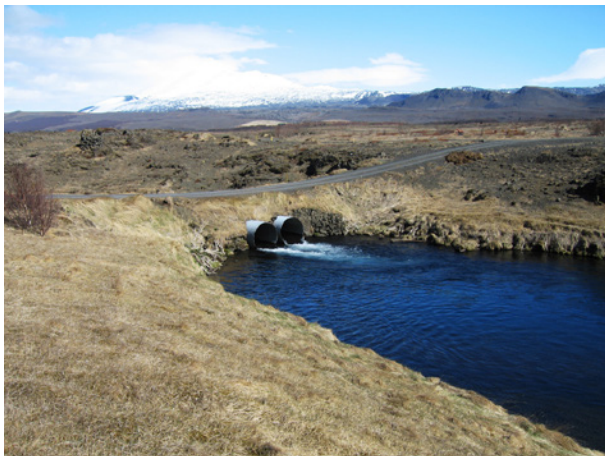
Hleðslur úr brú 012 sjást sitthvorumegin við ræsi undir vegi, horft til austurs.
