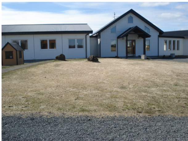
Hesthúshóll 008, horft til norðvesturs.
