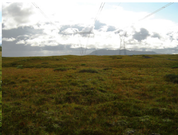
Garðlag 040B, horft til suðvesturs.
