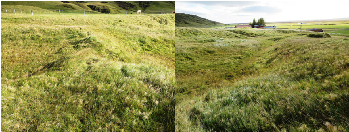
Stífla í áveitu 054, horft til suðausturs.
