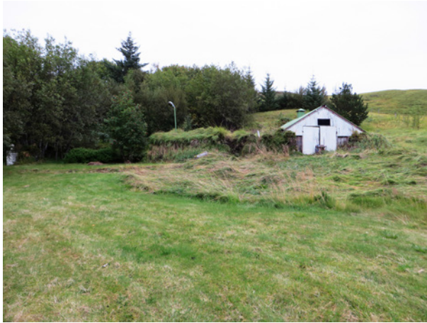
Fjós 002, horft til austurs.
