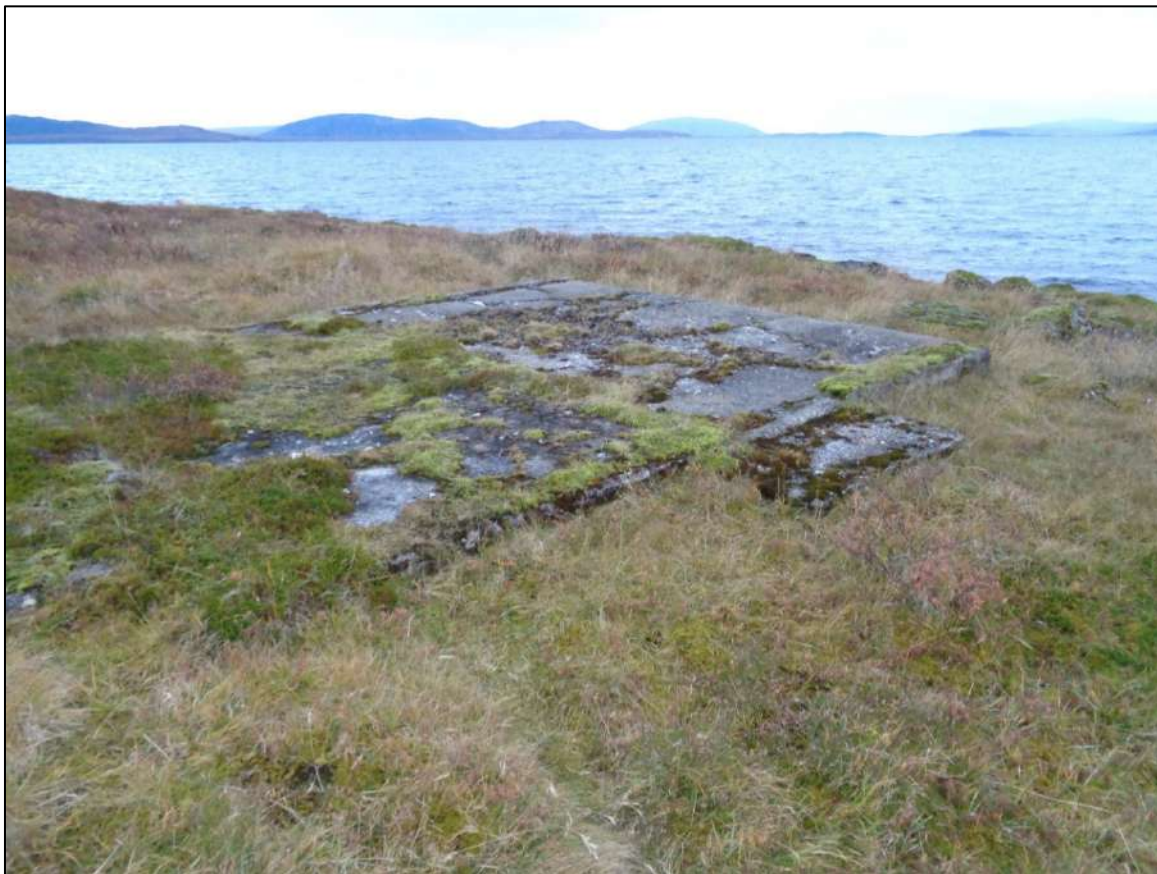
Mynd 13 Steypt gólfplata undan sumarbústað.
