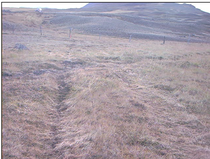
Mynd 1. Áveitustokkurinn eftir að ljósleiðarinn (lóðrétt lína) hefur verið lagður í gegn. Hann fór í gegn þar sem stokkurinn var lægstur og ógreinilegastur.
