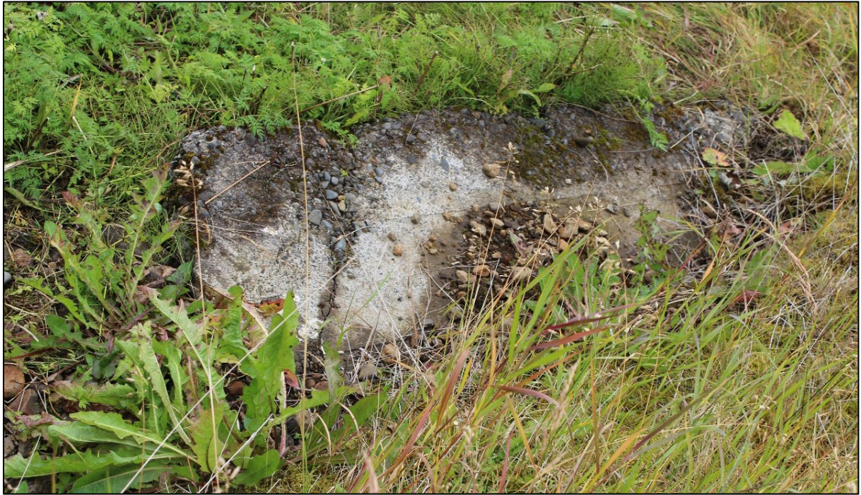
Mynd 10. Steyptur grunnur sem hefur tilheyrt virkjuninni.
