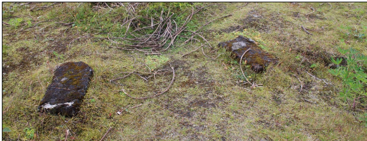
Mynd 8. Steyptar undirstöður vestan við veggjabrot frá virkjun.
