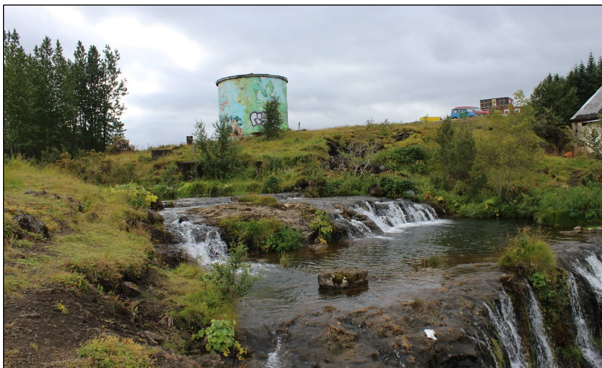
Mynd 9. Steypt undirstaða frá virkjuninni ofan við Álafoss.
