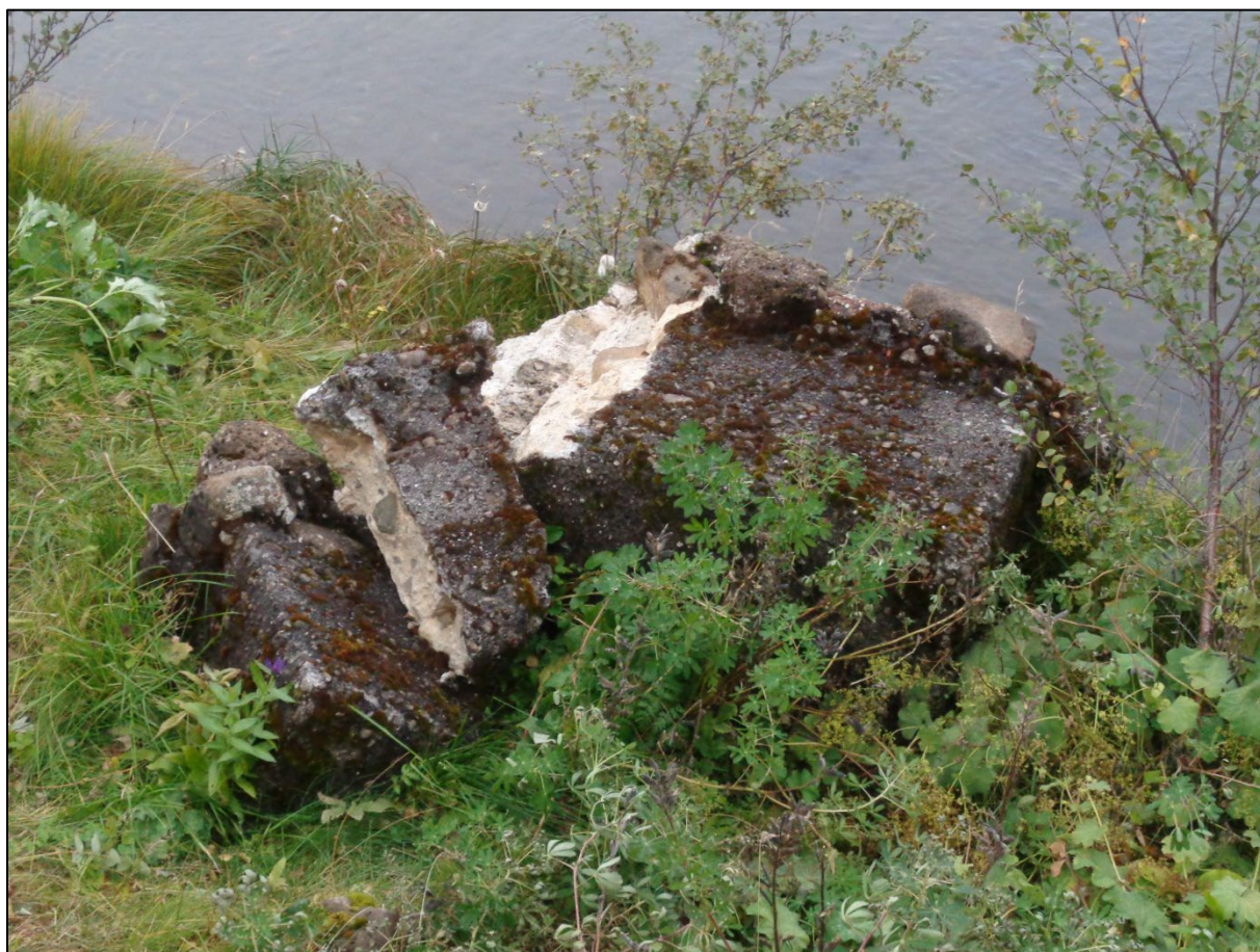
Mynd 16. Neðri dýfingarpallurinn [1943] við Varmá.
