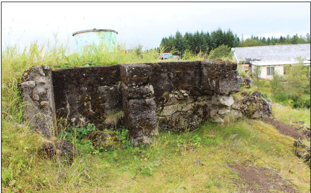
Mynd 11. Steyptur undirstöðuveggur á norðurbakka árinna.
