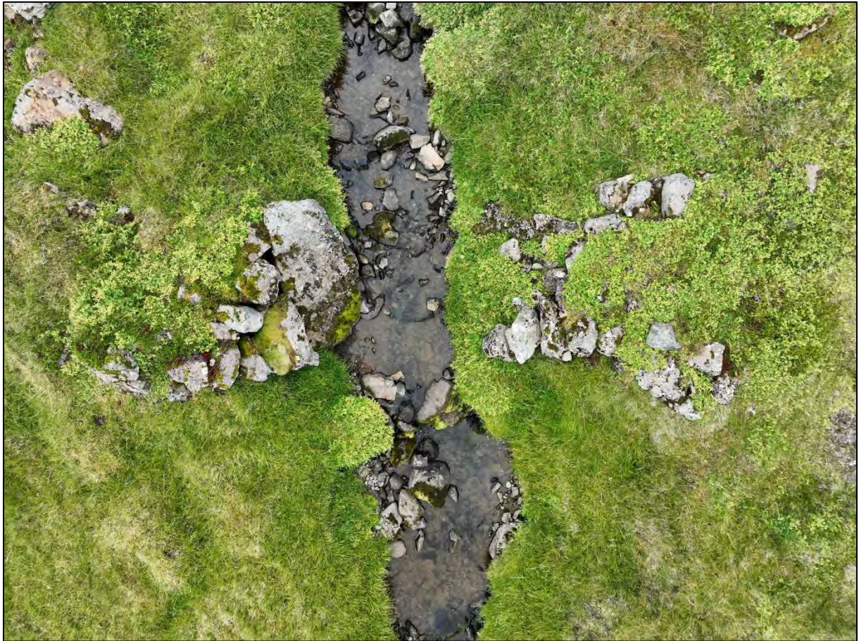
Mynd 34. Grjóthlaðnar undirstöður gamallar brúar [525] varðveittar beggja vegna lækjarins, þ.e. Austmannsdalsár.
