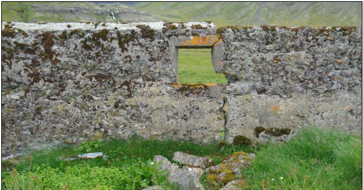
Mynd 11. Steinsteypur hlöðuveggur í tóft [502].
