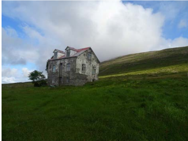
Öskuhaugur 023, horft til norðvesturs.
