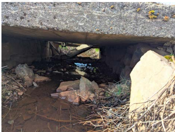
Brú 001_03, horft til SSV.
