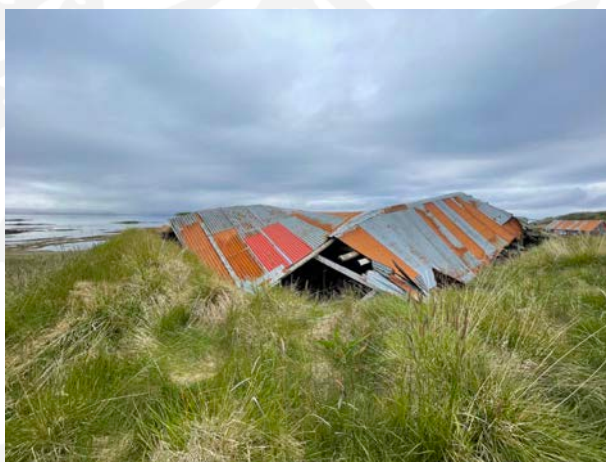
Fjárhús 004, horft til VSV.
