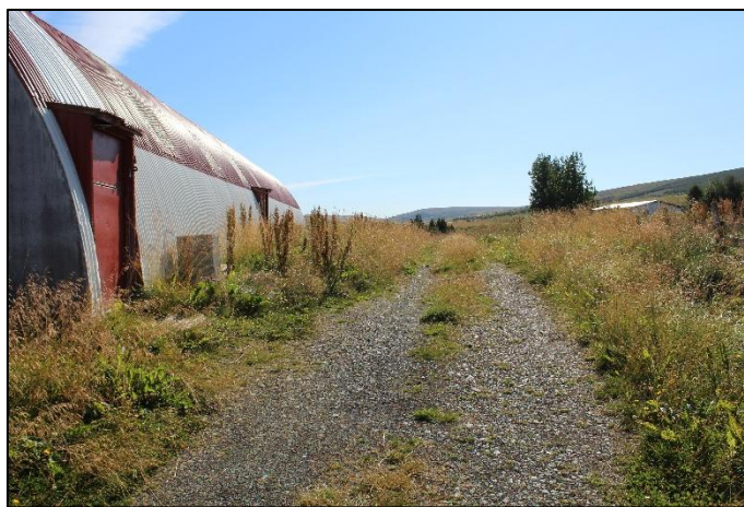
Mynd 11. Braggi og vegur ofan við hann á Kvíahól þar sem áður voru kvíar [3481-012], mynd tekin til suðurs.
