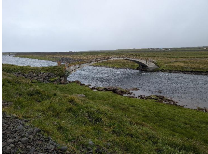
Mynd 23. Gamla brúin að Miðfjarðará, vinstra megin má sjá hlaðinn vegkafla [3465-022] að brúnni.
