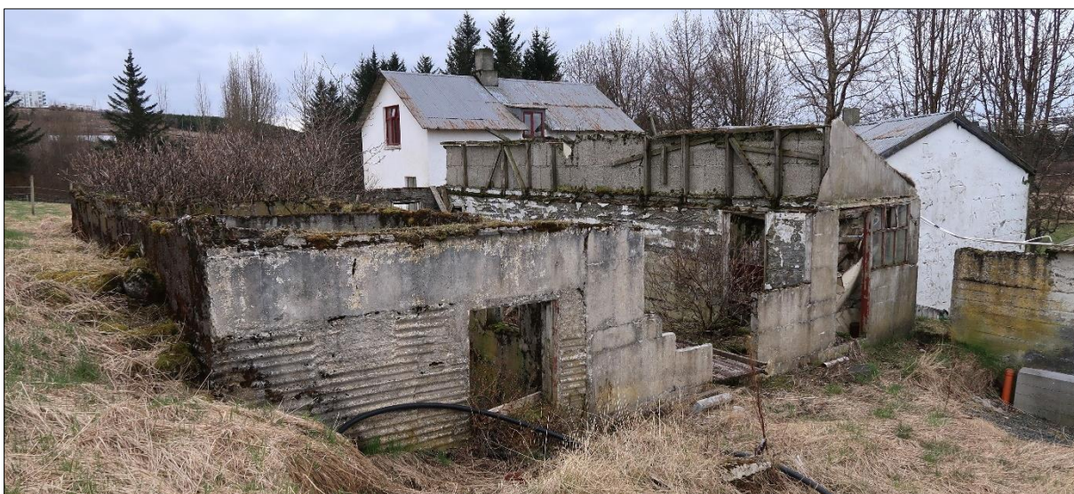
Mynd 83. Horft til suðurs yfir steinsteyptar tóftirnar, fjárhús og hlöðu (264-44).
