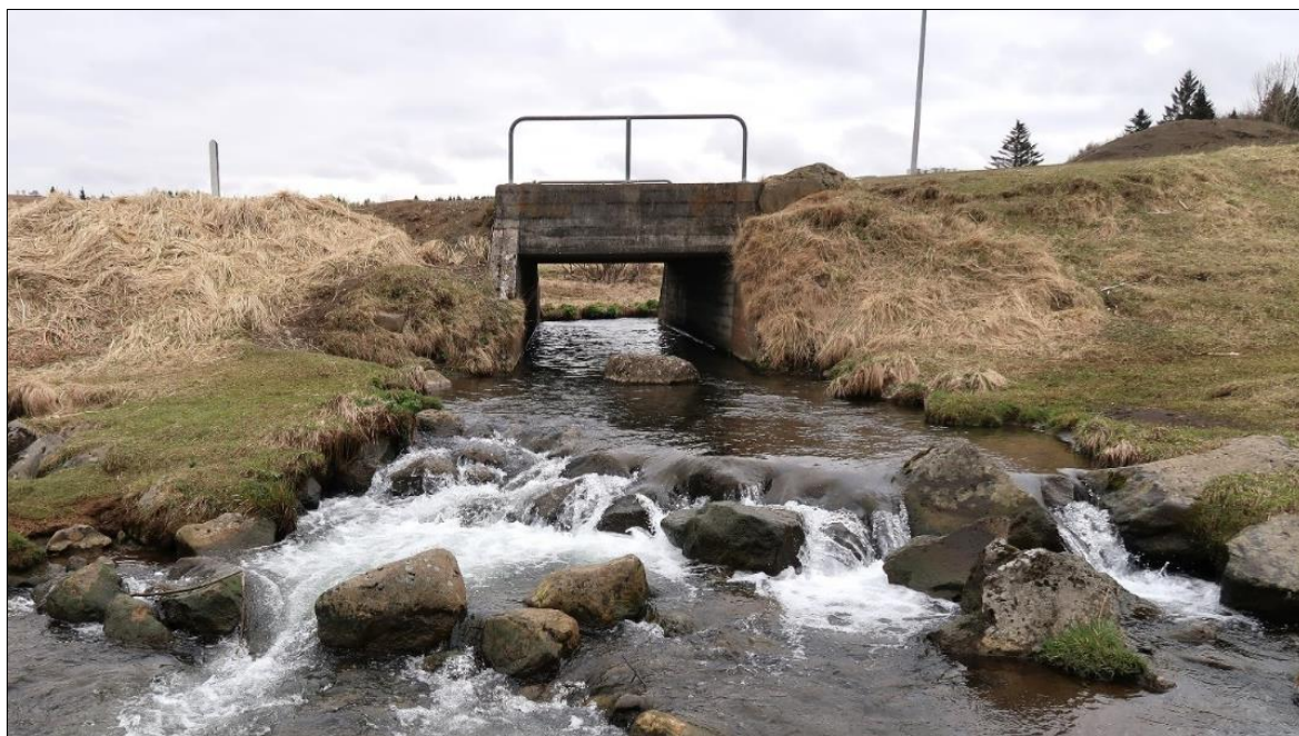
Mynd 190. Horft til austurs að brúnni yfir Grafarlæk.
