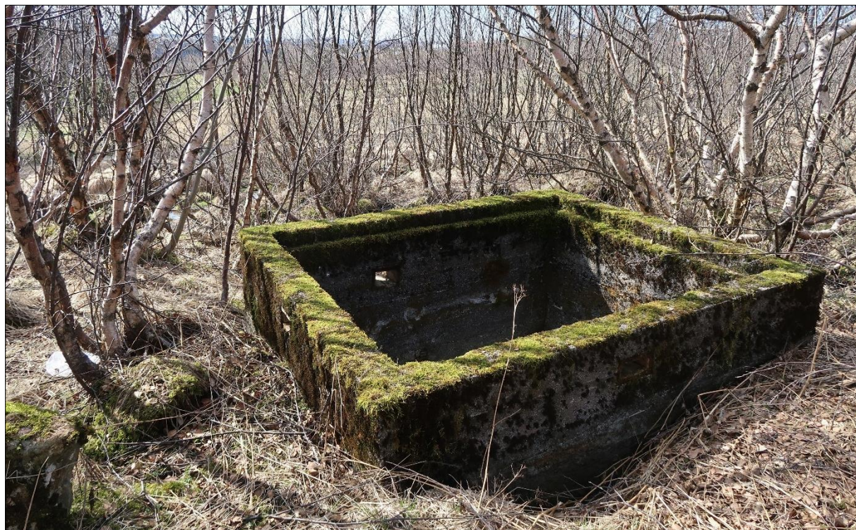
Mynd 38. Steinsteyptur brunnur (264-12) norðan við hús nr. 9 við Keldnaveg.
