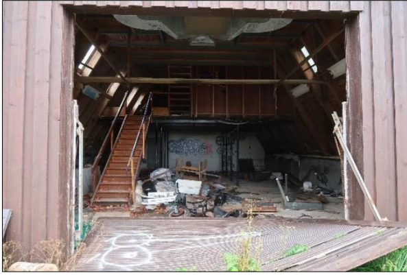
Mynd 209. Horft til suðausturs inn í vélageymsluna.
