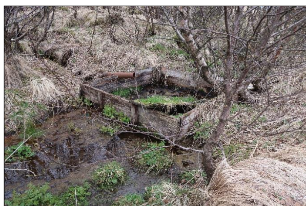
Mynd 39. Horft til austurs yfir trékassa fyrir neðan brunninn.
