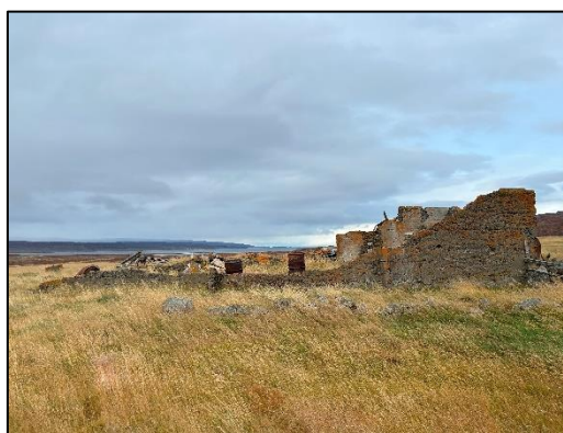
Mynd 32. Horft í vestur yfir fjárhús 3121-019.
