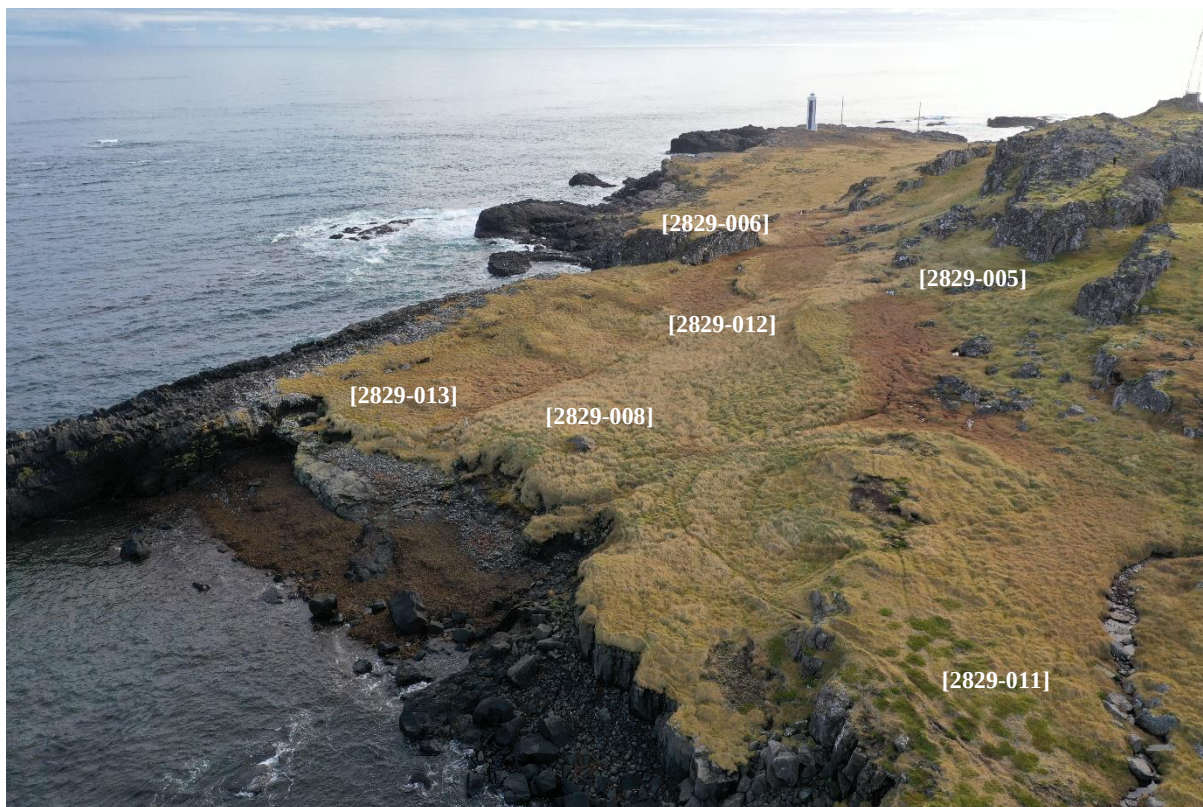
Mynd 11. Horft til suðurs yfir minjar við Geitólfsvík. Á myndinni má sjá jarðsokknar tóftaleifar, mögulega af sjóbúð eða stekk [2829-008]. Þarna sést hvernig mannvirkið er byrjað að brotna í sjó fram. Hleðsla með óþekkt hlutverk [2829-013] er vinstra megin við stekkinn. Aðrar minjar í umhverfi vikunnar eru merktar inn með númerum.
