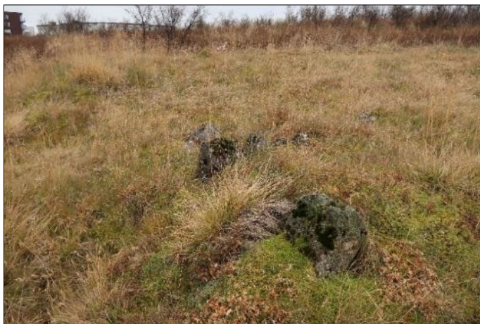
Mynd 21. Steypuleifar (259-50) á nyrðri grunni, horft til suðvesturs.
