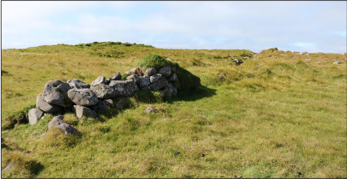
Mynd 51. Syðsti hluti túngarðsins [1018] við Kílsnes.
