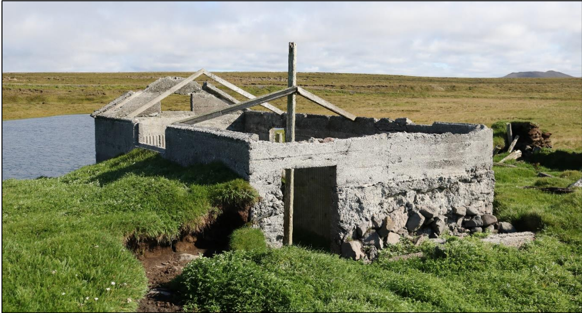
Mynd 65. Steinsteyppt hlaða [1009].
