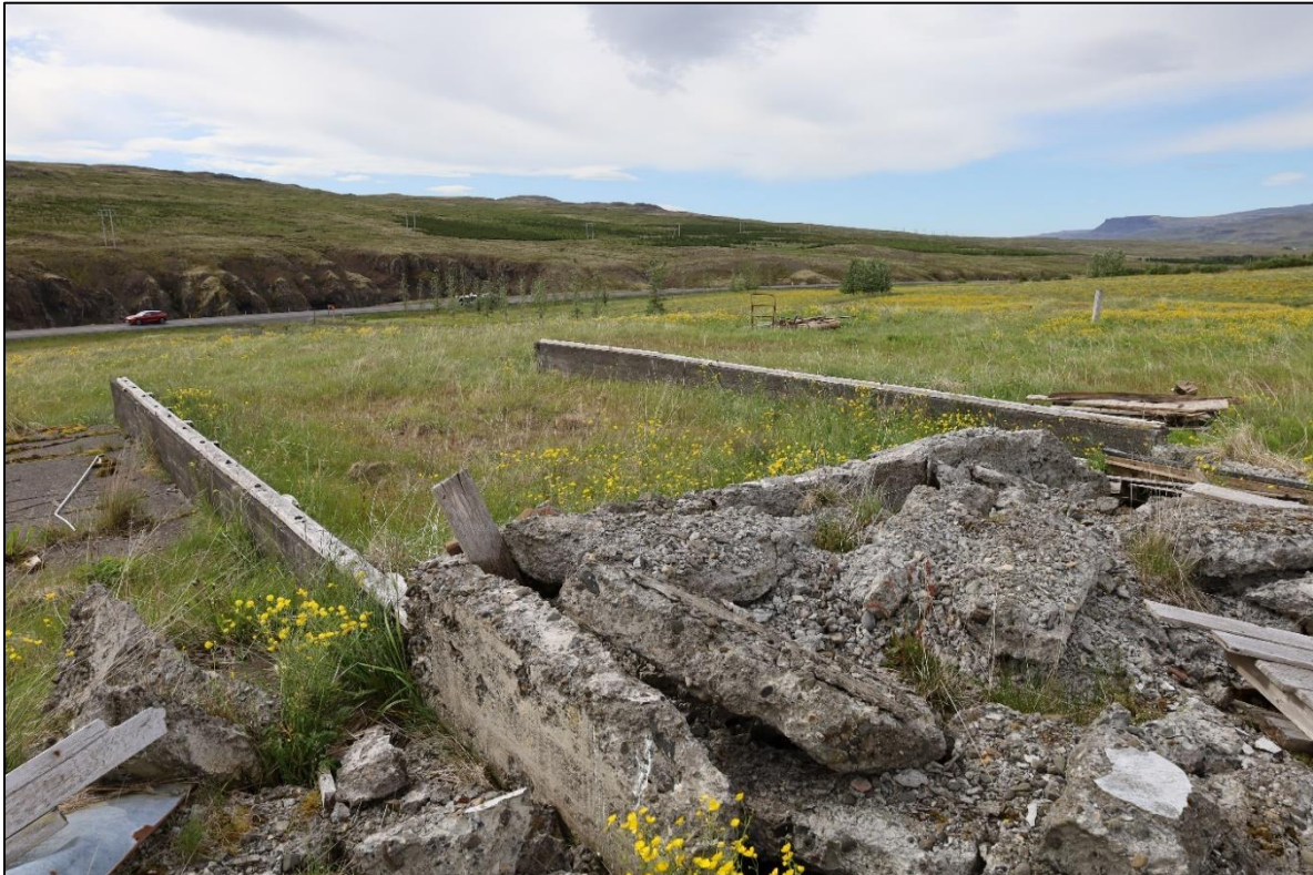
Mynd 23. Húsgrunnur hlöðu [165] með steypa veggi og stétt. Viður og bárujárn fundust einnig í grunninum.
