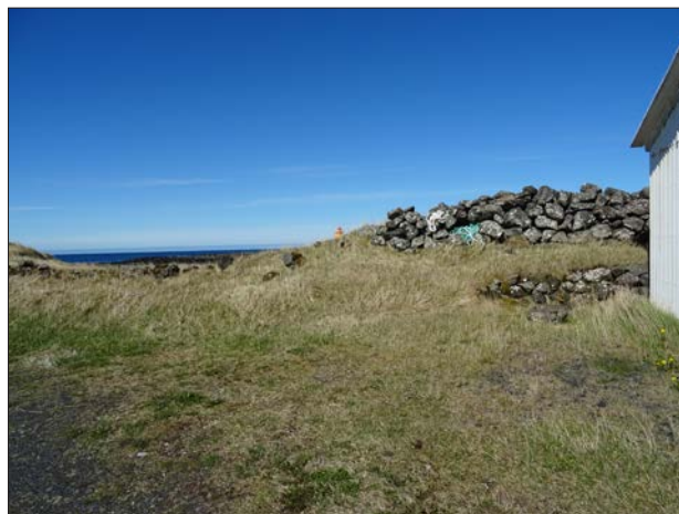
1850-266: Horft til norðurs yfir varnargarðinn.
