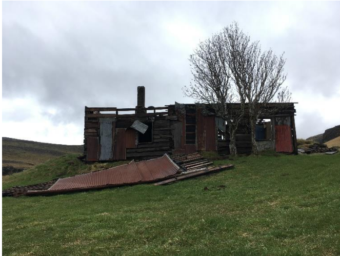
Hús 02, horft til norðurs.
