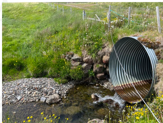
Brúarstæði 111 árið 2024, horft til norðvesturs.
