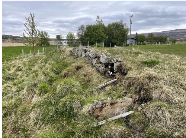
Túngarður 031, horft til ANA.
