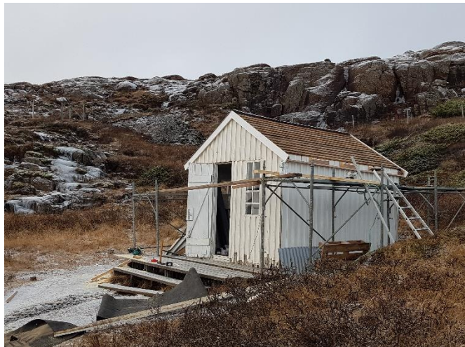
Unnið að lagfæringu á þaki hússins haustið 2020. Mynd: EGB
