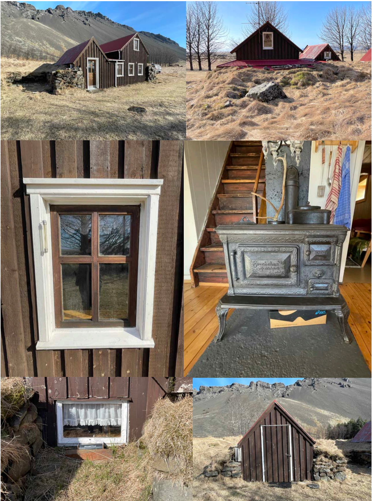
Mynd 6. Suður- og norðurhlíðar Raðabergs II (efst) með íbúðarhús að austan og forstofu og bað að vestan. Gluggarnir að sunnanverðu (miðja til vinstri) eru faldaðir og með vatnsbretti á meðan stofuglugginn að austan (neðst til vinstri) og svefnherbergisglugginn að norðan (efst til hægri) eru einfaldir. Geymslan (neðst til hægri) er byggð 1996 í smíðjutóftinni. Gamla kolaeldavélin er frá tíð Elíasar bónda (miðja til hægri) en hvort hún er eldri en það er óljóst.
