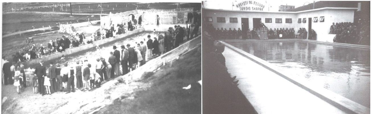
Sundlaug Ólafsfjarðar í byggingu sumarið 1944 á mynd til vinstri en á mynd til hægri er sundlaugin á vígsludegi 1945. Báðar myndir eru úr Íðnsögu Íslendinga bls. 363 og 364
