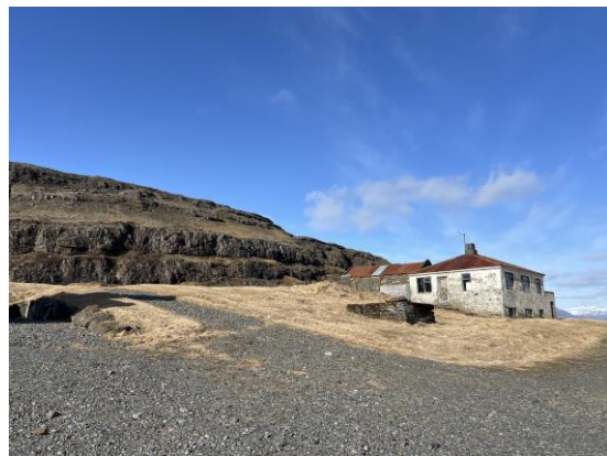
Mynd 12. Bæjarhóllinn að Uppsölum, horft til norðurs.
