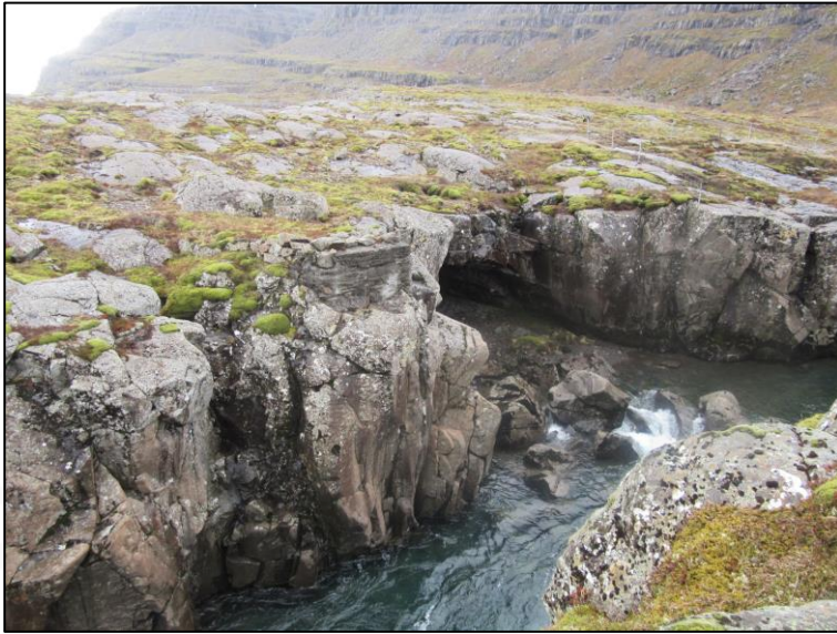
Undistöður brúar 009, horft til suðausturs
