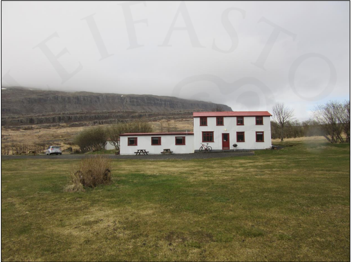
Bæjarstæði Eyjólfssstaða 213:001. Íbúðarhúsið, sem byggt var árið 1922, er í dag notað sem gistiheimili
