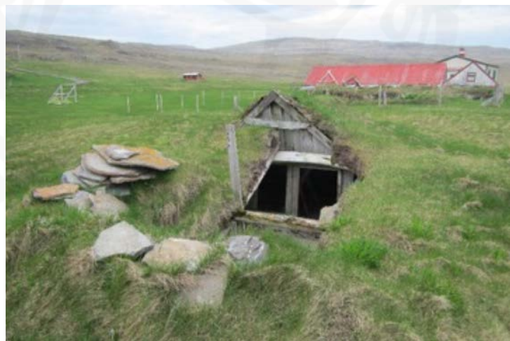
Hagamannabúð 048A, horft í suður.
