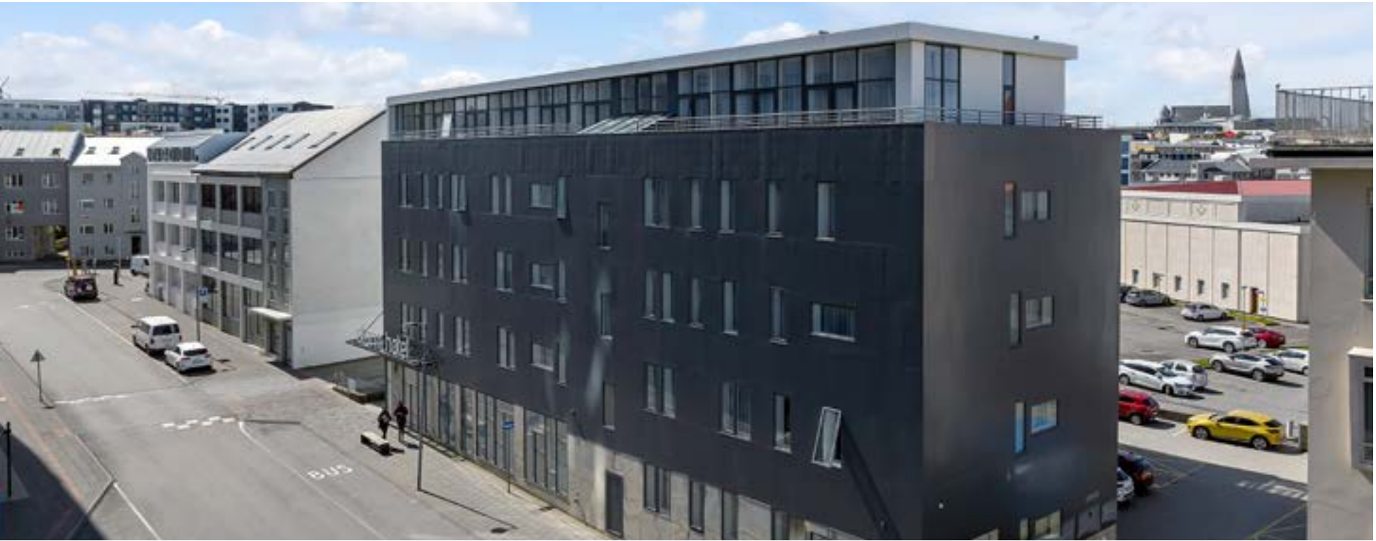
Bórunnartún 4 Reykjavík 2.953 m2
