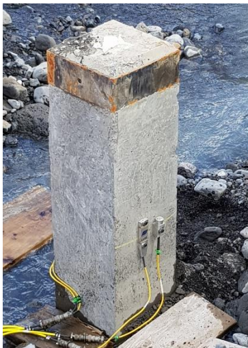
MYND 15 Búið að festa hröðunar- og streitunema á staur.
