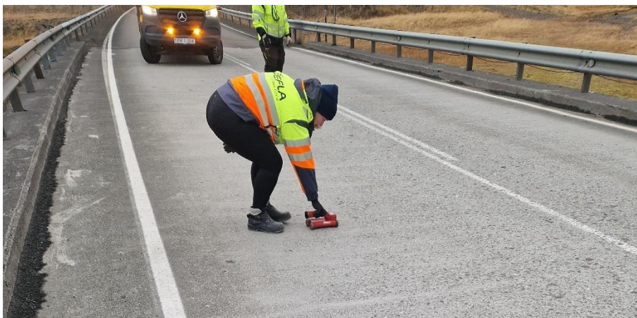
MYND 4 Steypuhula á járn mælt með járnaskanna.
