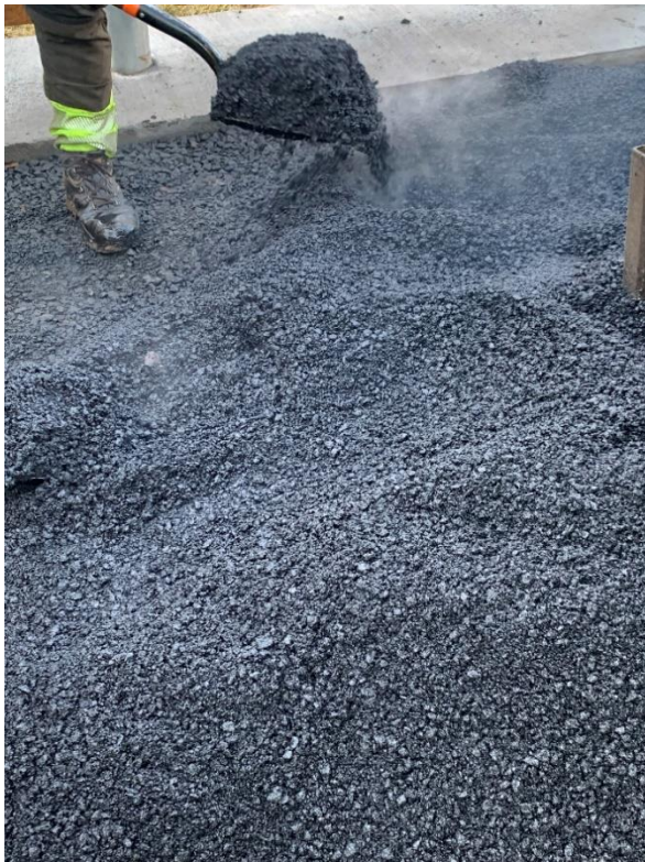
Mynd 1 Malbik blandað með lífbindiefni í útlögn. Enginn sjáanlegur munur á malbiki með lífbindiefni og hefðbundnu malbiki.
