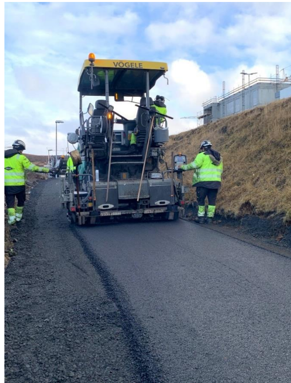
Mynd 1 Malbik blandað með lífbindiefni í útlögn. Enginn sjáanlegur munur á malbiki með lífbindiefni og hefðbundnu malbiki.
