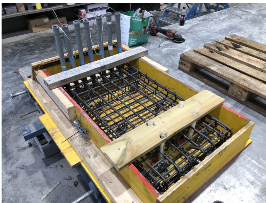
Mynd 2-13: Veggeining fyrir FSL-LS klár til steypu. Rörin sjö eru fyrir K10 járnin sem þrædd verða í gegn eininguna.
