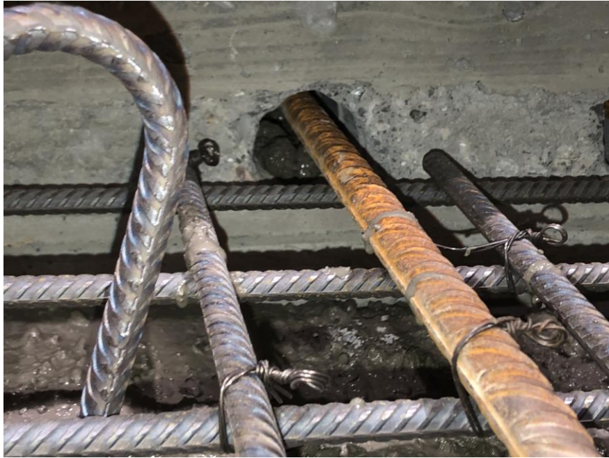
Mynd 2-18: Steypuvinna í gangi. Steypa að flæða í gegnum göt á FSL-SS einingunni.
