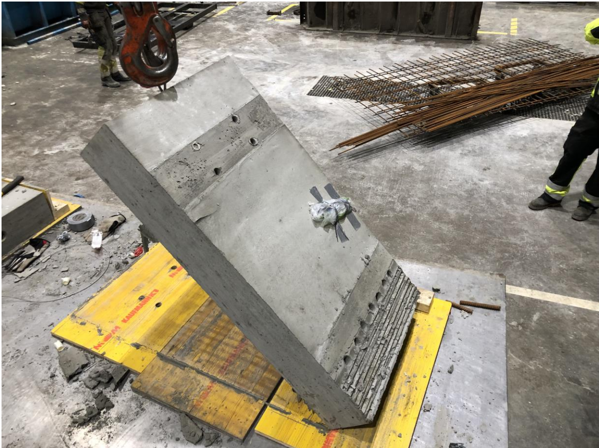
Mynd B 5: Stöpulveggur FSL-LS eftir fráslátt steypumóta. Verið er að reisa vegg og gera hann kláran fyrir næstu steypuvinnu.
