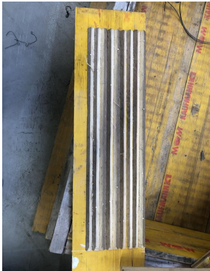
Mynd 2-9: Þríkantslistar festir á platta sem þrýst er ofan í steypu þar sem veggur er steypur liggjandi.
