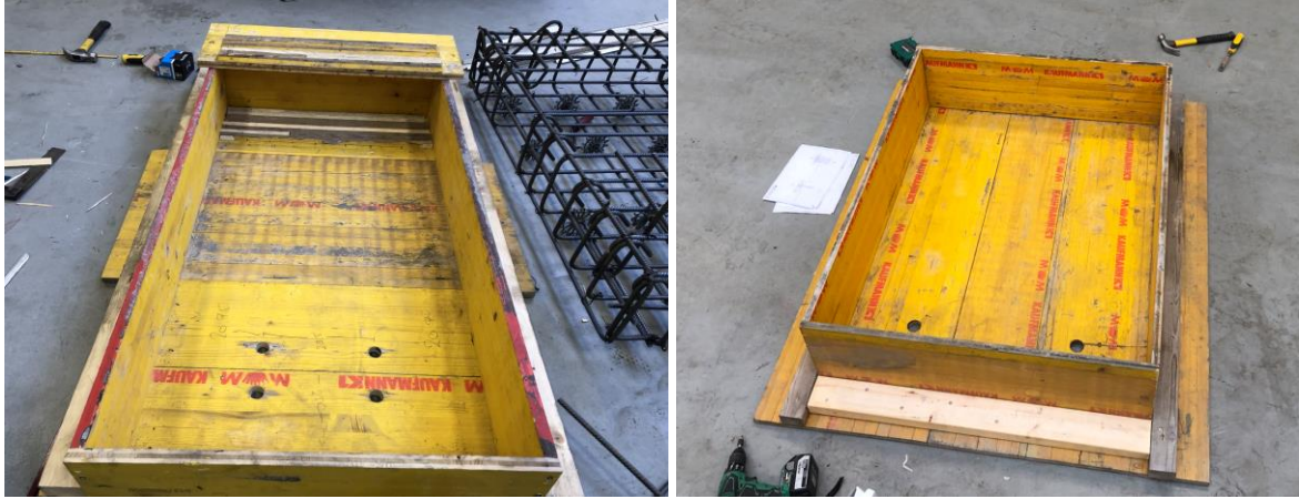
Mynd B 1: Smíði steypumóta fyrir FSL-LS í vinnslu.
