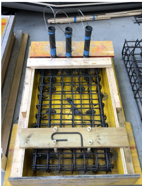
Mynd 2-12: Veggeining fyrir FSL-SS klár til steypu. Rörin þrjú eru fyrir K16 járnin sem þrædd verða í gegn eininguna. Færri rör einfalda mótasmíðina.
