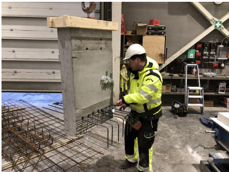
Mynd 2-15: Langjárnur komið fyrir í FSL-LS áður en veggur er hífður í sökkulgrind.
