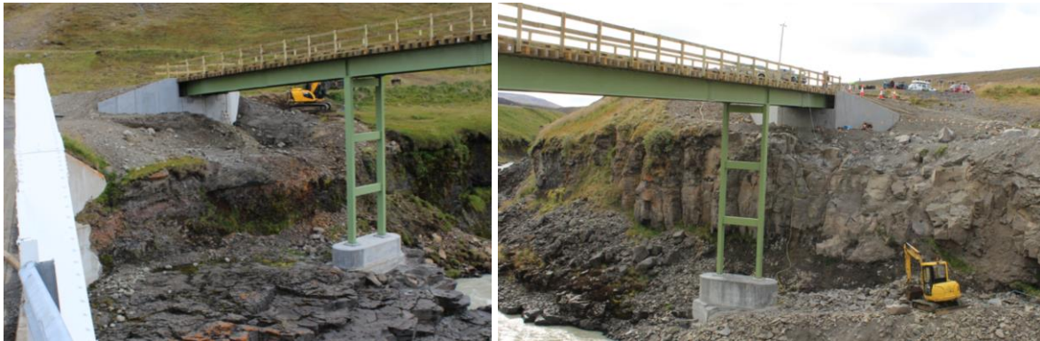
Mynd 1-3: Austurstöpull (vinstri) og vesturstöpull (hægri) brúar yfir Jökulsá á Dal (Vegagerðin).
