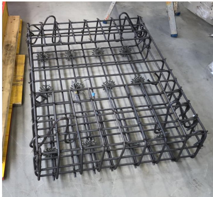
Mynd 2-11: Járnagrind sökkuls í smíði.
