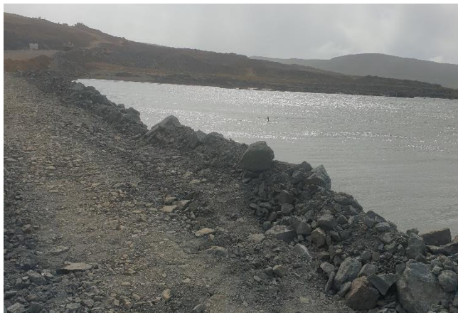
Mynd 10 – Sigslanga út í sjó, sett niður í fyrsta áfanga við þverun Þorskafljarðar.
