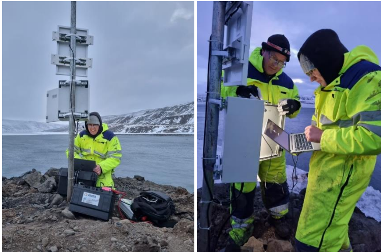
Mynd 22 – Mæliskápur var settur upp á fyllingunni til að taka á móti mælingum aflögunarmælisins, en úr honum má einnig nálgast niðurstöður mælinga beint.
