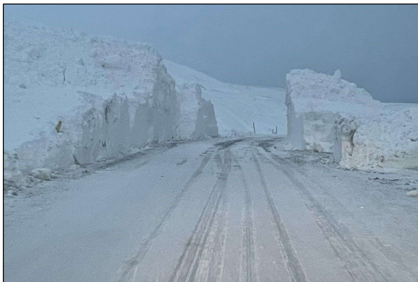
Mynd 22. Ólafsfjarðarvegur þegar búið var að moka í gegnum annað snjóflóðið.
