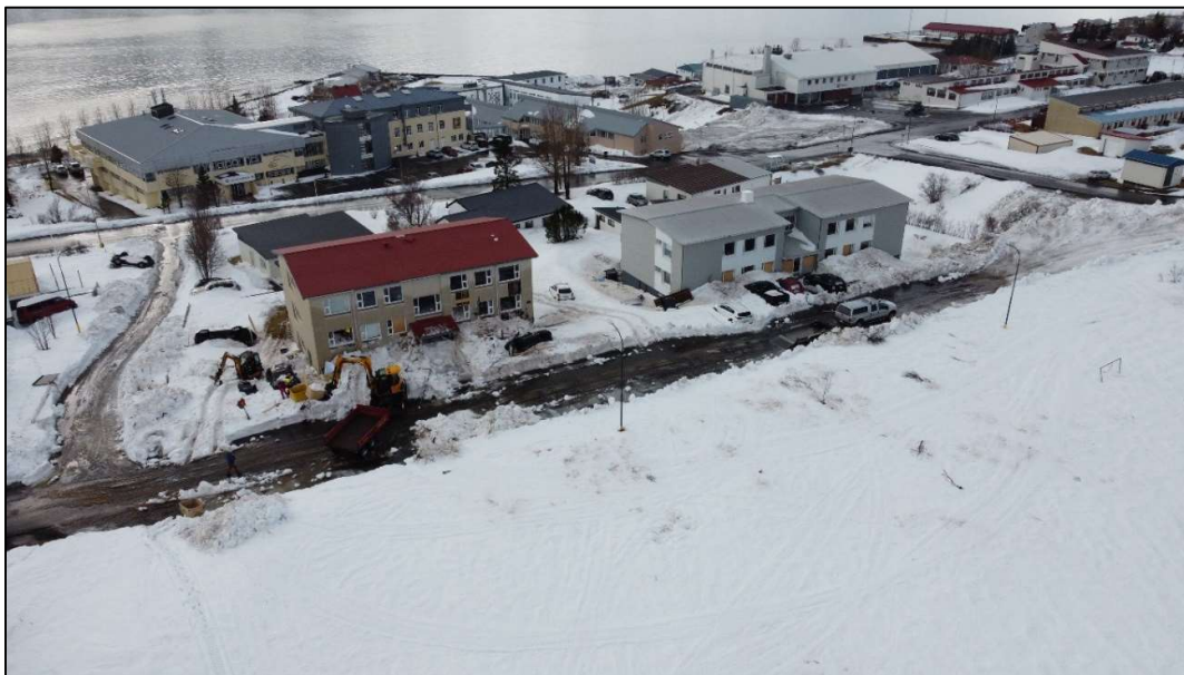
Mynd 36. Snjóflóðið skall á tveimur fjölbýlishúsum, fór inn í íbúðir og stigagang og olli tjóni á nokkrum húsum
