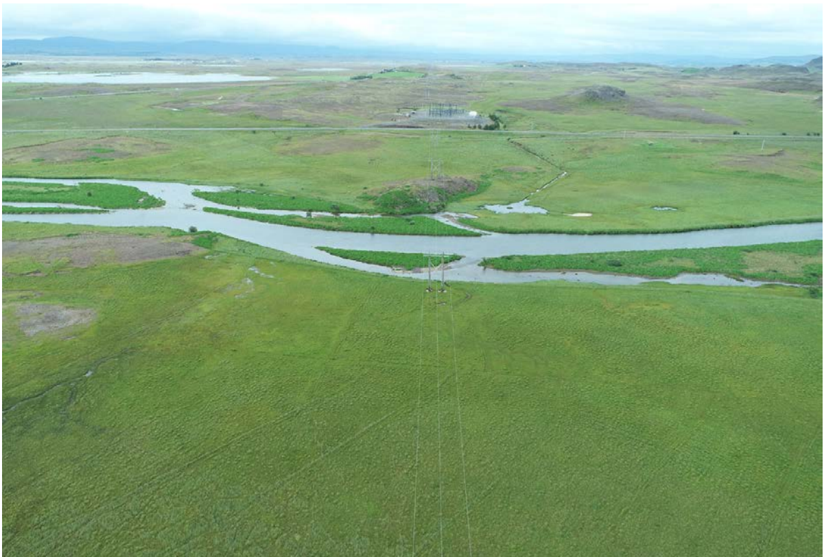
6. mynd. Áreyrar Andakílsár eru þaktar lúpínu en gróskulegt votlendi er beggja vegna árinna. Ofan við Skorradalsveg glittir í tengivirkid á Vatnshömrum þar sem línuleið á A-hluta lýkur. Ljós. Sigurður Kristinn Guðjohnsen, 10. ágúst 2022.
