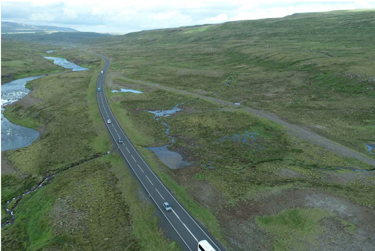
36. Ljósmynd. Fornihvammur B (43). Afmarkað efnistökusvæði er beggja vegna Hringvegar. Hægra megin við veginn sjást greinileg ummerki eftir fyrrum efnistöku en nær Norðurá er lítt raskaður mosagróinn melkollur og undir honum er gróskuleg blómadæld við ána. Ljósmynd. Sigurður Kristinn Guðjohnsen, 12. ágúst 2022.
