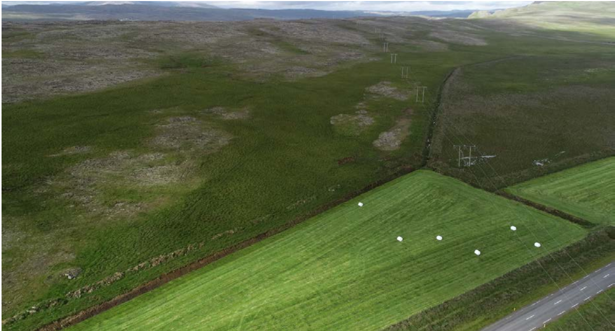
28. mynd. Hér liggur byggðalínan yfir Borgarfjarðarbraut og Veggjaháls. Á þessum kafla fylgja allar línuleiðir á C-hluta byggðalínu yfir túnið og votlendið framan við hálsinn en þar skiljast svo leiðir þar sem valkostur C (og samanburðarkafar C1a/C2a og C3a/C4a) fer yfir hálsinn en C1–C4 liggja meðfram honum til norðausturs. Ljós. Sigurður Kristinn Guðjohnsen, 3. ágúst 2022.
