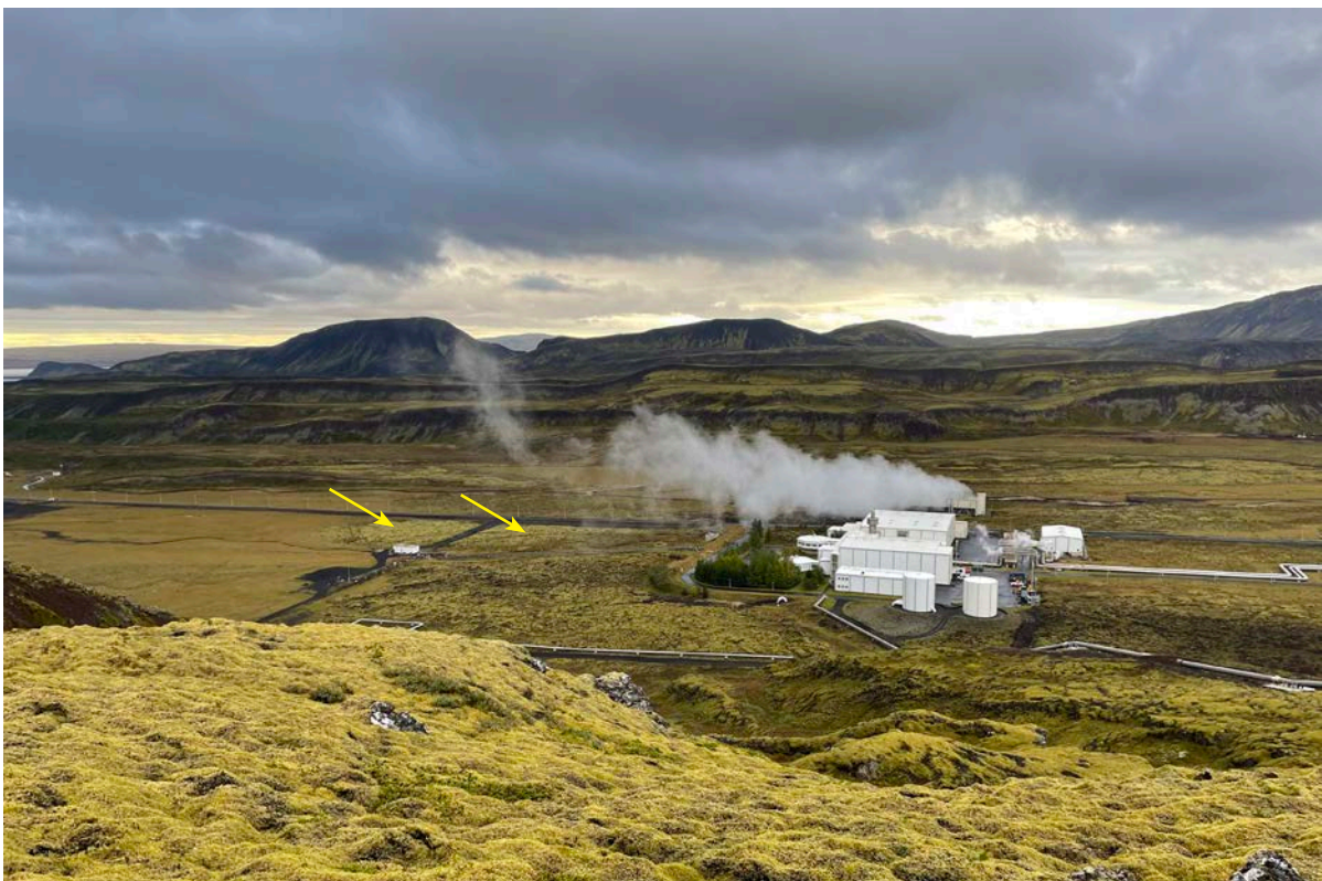
50. ljósmynd. Yfirlitsmynd við Nesjavallavirkjun tekin úr reit V-500. Mosaskemmdir sjást einnig aðeins norðan við virkjun (vinstra megin við stöðvarhúsið á mynd). Örvar sýna u.þ.b. legu reita NA-250 og NA-500. Ljós. Járngerður Grétarsdóttir, 29. ágúst 2022.
