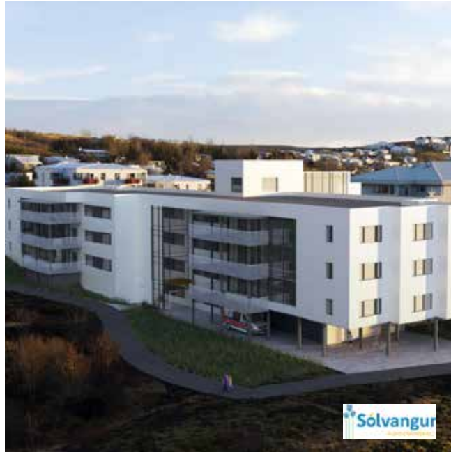
Nýbygging Sólvangs í Hafnarfirði
