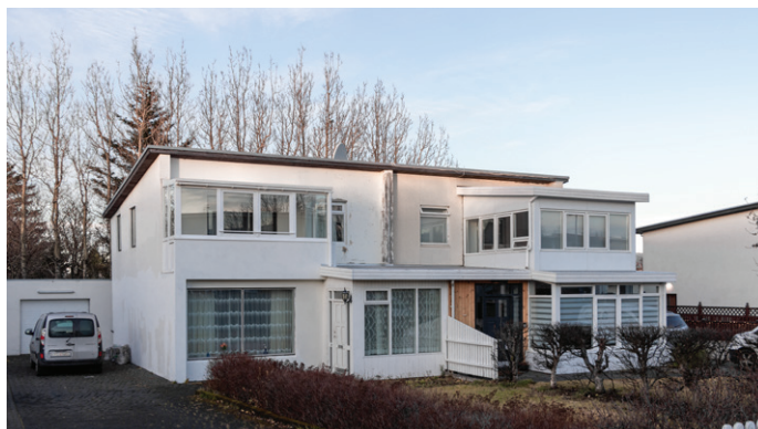
Mynd 140: Viðhengi og viðbætur. Skólagerði 54-56
