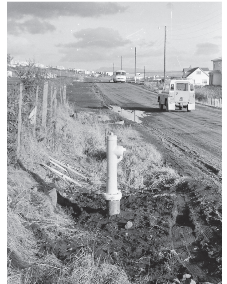
Mynd 19: Kópavogsbraut. Vatnshani í forgrunni, heflaður vegur, rafmagnsstaurar og strætisvagn í bakgrunni. Án ártals.
