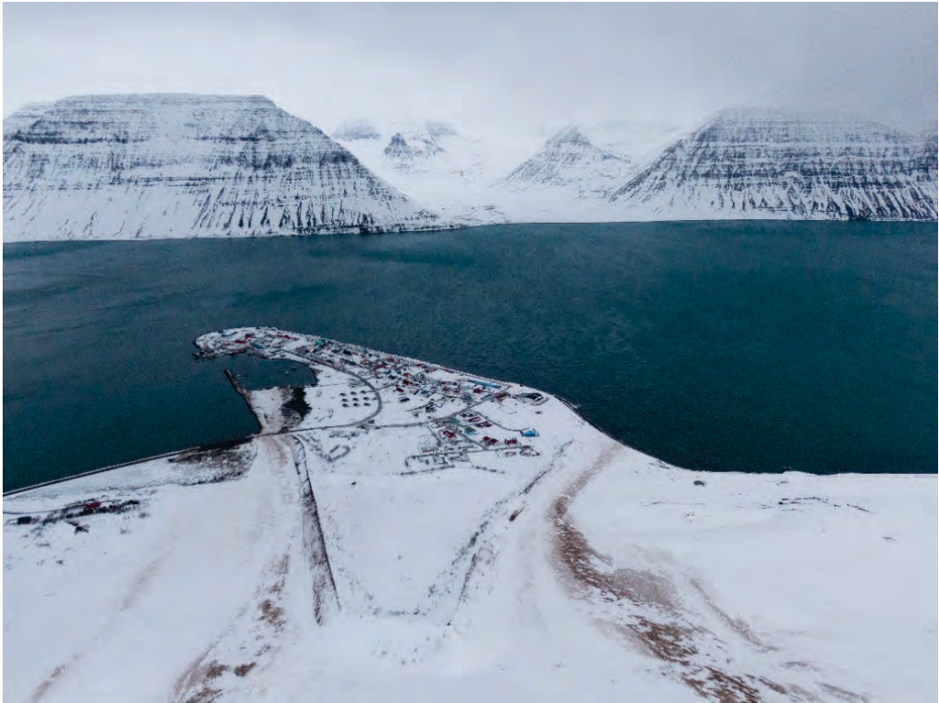
Mynd 20. Loftmynd úr flygildi sem sýnir vel hvernig varnargarðarnir náðu að stýra þetta kjarna snjóflóðanna frá byggðinni. Íðufaldurinn sem flæddi yfir var hreinn, eðlisléttari snjór. Vel má sjá ummerkin um yfirflæðið á báðum leiðigörðunum og á endum þvergarðsins. Ljósmynd: Haukur Sigurðsson.
