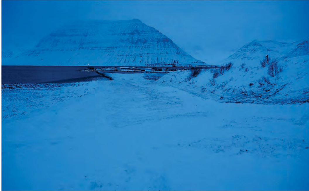
Mynd 17. Horft í flóðstefnu þetta kjarnans að höfninni. Vel má greina stallinn í flóðsnjónum þar sem sjávarfalla gætti og tjörnina neðan við veginn. Neðri radarinn stendur efst á leiðigarðinum, óskaddaður. Einnig má sjá greinilega lárétta línu á varnargarðinum sem sýnir hversu hátt þétti kjarninn náði.
