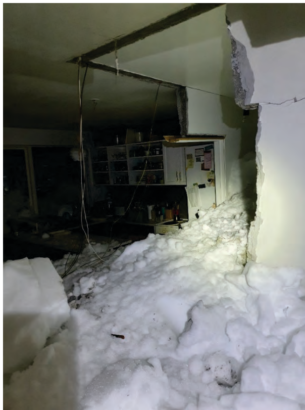
Mynd 42. Horft af ganginum og inn í eldhúsið. Hlaðnir milliveggir brotnuðu í flóðinu.
