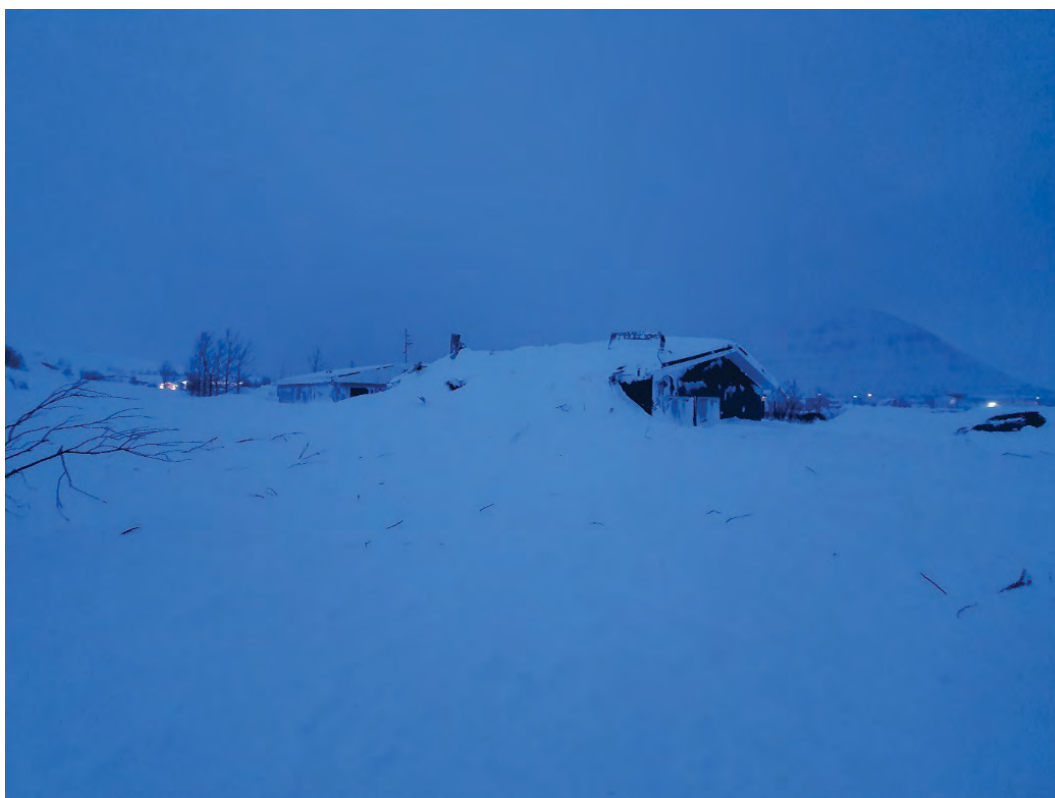
Mynd 39. Ólafstún 12 og 14. Flóðsnjór hylur nánast alveg útvegg Ólafstúns 14 en lítill flóðsnjór við Ólafstún 12. Greinabrak sem kom úr varnargarði er víða í snjónum.
