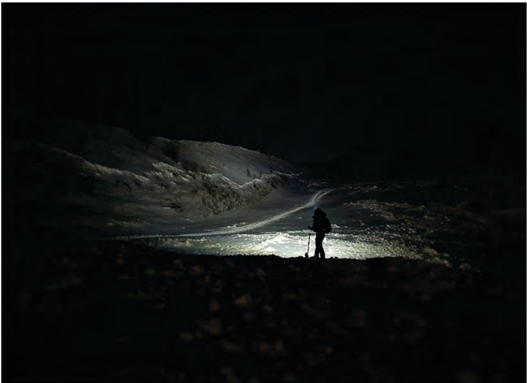
Mynd 21. Horft upp eftir leiðigarðinum undir Skollahvilft. Greinileg ummerki um þetta kjarnann sáust á neðri hluta garðsins en ekki merki um yfirflæði. Ofan við miðjan leiðigarðinn hafði allur snjór sópast af garðinum með yfirflæðinu.
