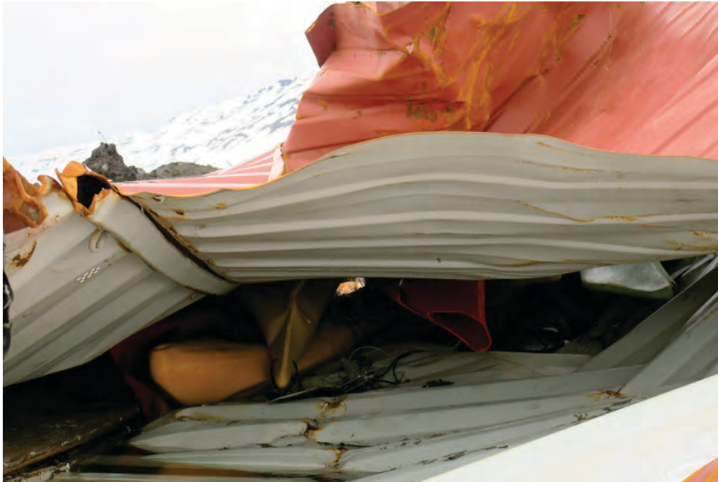
Mynd 30. Gámur með búnaði ferðaskrifstofufyrirtækis lagðist saman í flóðinu.
