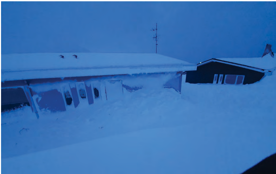
Mynd 38. Ólafstún 12 og 14. Greina má flóðsnjó meðfram horninu á Ólafstúni 12 en engar skemmdir. Loftnetið á Ólafstúni 12 er enn á húsinu en mikil eyðilegging á Ólafstúni 14 nokkrum metrum frá þar sem þakið var byrjað að losna frá.
