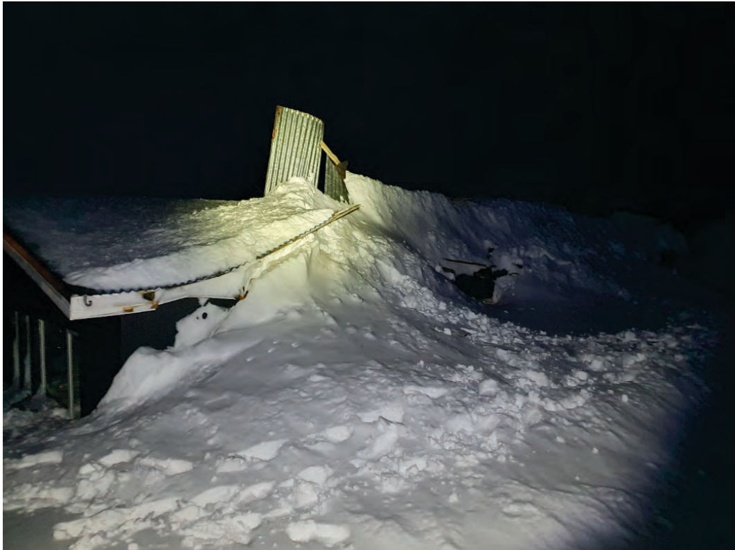
Mynd 37. Ólafstún 14 og hliðin sem snýr upp í fjall. Þakplötur og sperrur hafa hálfriðnað af og snjór kíttast inn í glufur. Flóðið braut sér leið innum glugga á herbergi unglingsstúlku og þar safnaðist minni snjór fyrir ofan húsið. Tvö börn sváfu í herberginu sem er lengst til vinstri á myndinni. Þar er enginn gluggi sem snýr að fjallinu, en mikill snjór safnaðist að útvegg og þakplötur voru byrjaðar að rifna af.
