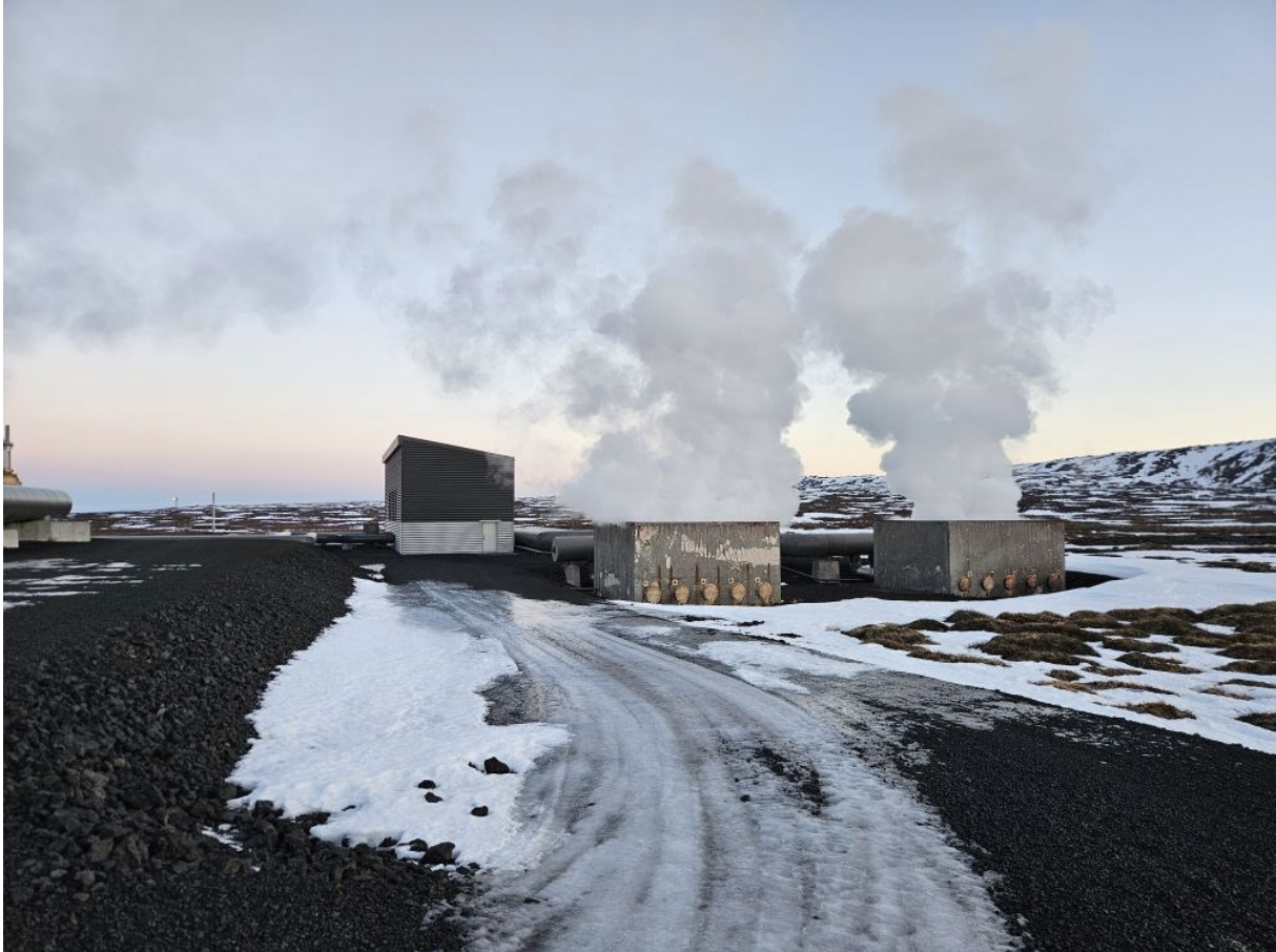
6. mynd. Mannvirki í suðausturhorni lóðar Þeistareykjavirkjunar. Þar er gufu hleypt út um s.k. lokahús. Mynd: Hreinn Hjartarson 2024.
