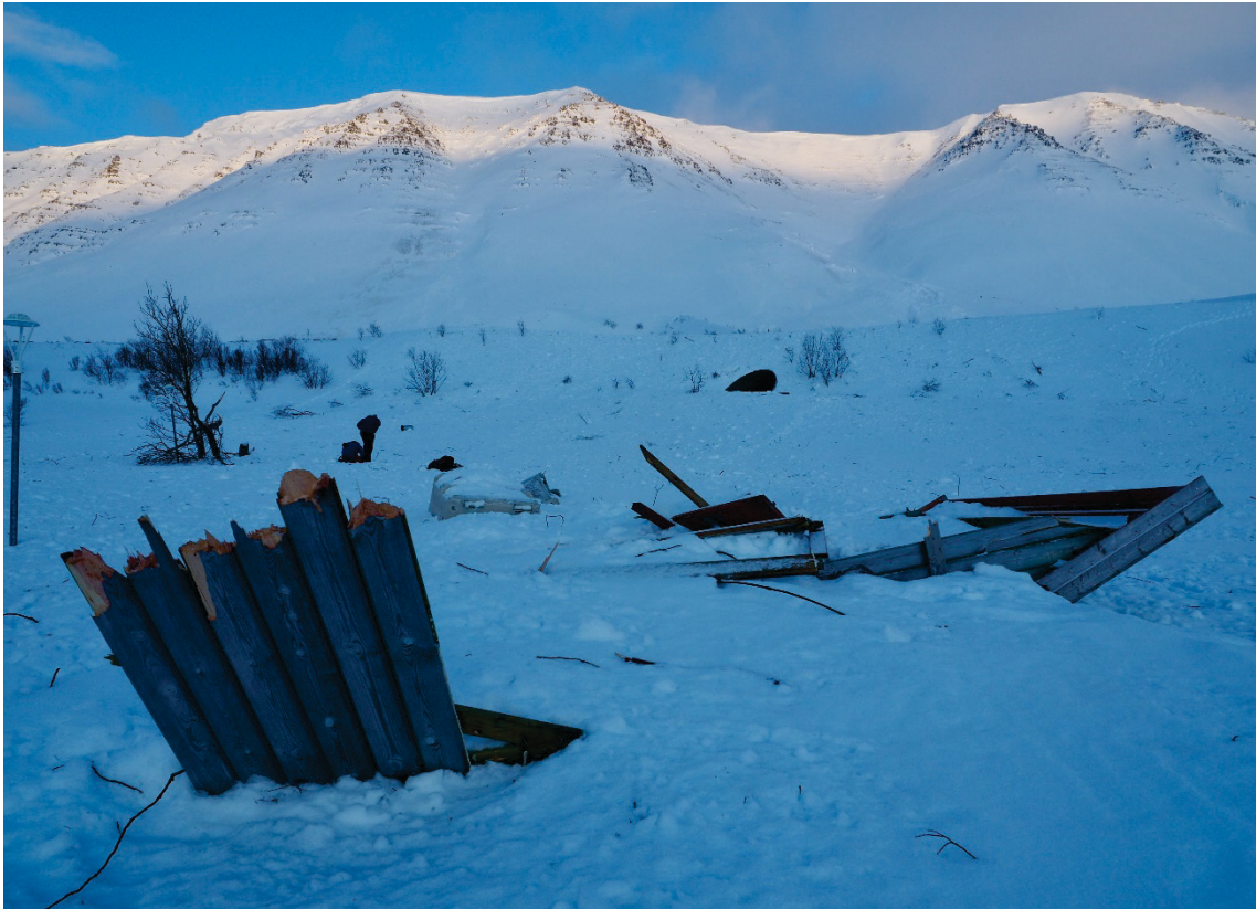
Mynd 15. Brak garðskýlisins við kirkjugarðinn. Fiskikör og brotið tré fyrir ofan.
