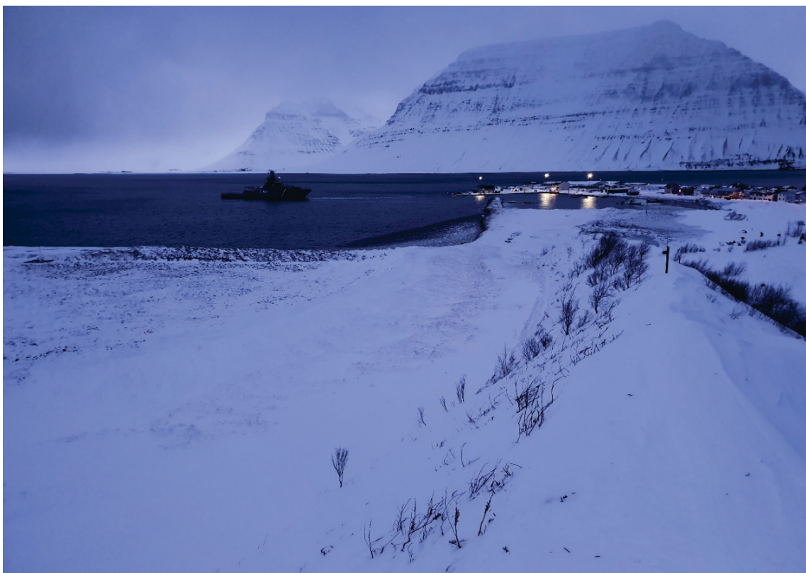
Mynd 16. Horft eftir varnargarðinum að höfninni á Flateyri. Sjá má hvernig varnargarðururinn beindi megninu af flóðinu frá byggðinni en að höfninni. Neðri ratsjáin stendur efst á leiðigarðinum, ósködduð.
