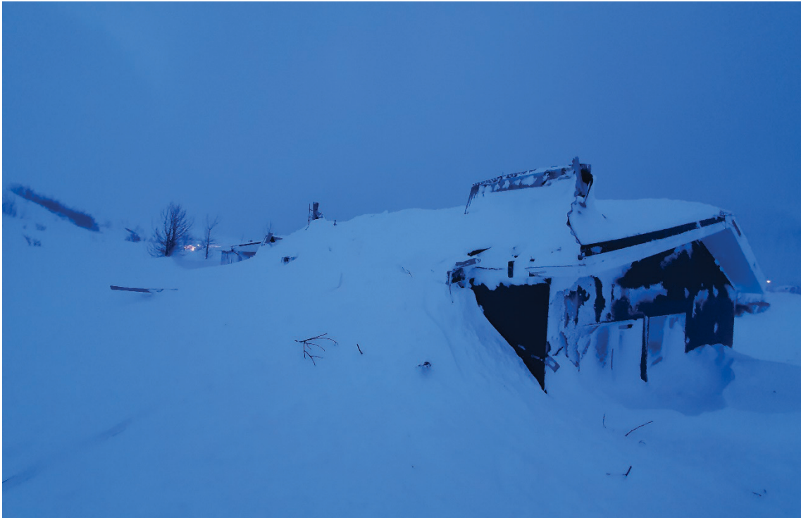
Mynd 19. Ólafstún 14 og hliðin sem snýr að fjallinu. Flóðið braut sér leið inn um hurð og alla glugga á efri hlið hússins. Mikill snjór safnaðist að útvegg og þakplötur byrjuðu að rifna af.
