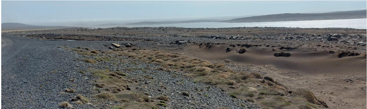
Mynd 1. Horft til suðurs yfir sandgildirur syðst á Kofaöldu, fjær ný sandgildra sem lítið efni hefur safnast í en talsvert mikið efni í sandgildru nær.
