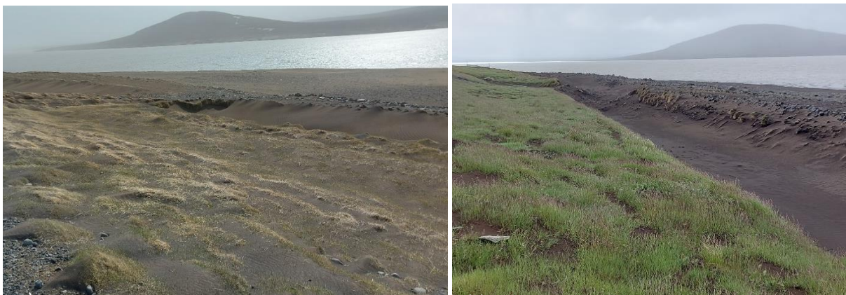
Mynd 7. Sandgildra neðan vegar á Lindabungu, annars vegar hálf full af áfoksefnum 30. maí 2023 (mynd a) og hins vegar 4. júlí (mynd b) eftir að efni hafði verið hreinsað úr skurðinum.
