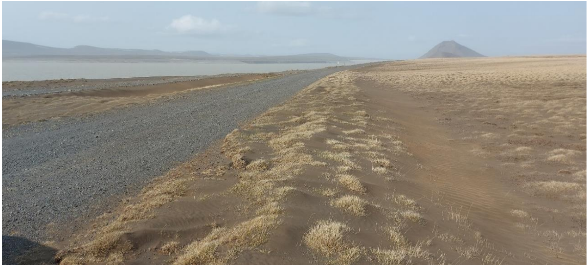
Mynd 11. Haft milli sandgildra þar sem vantar fokgirðingu og mikið af sandi hefur borist yfir veginn.
