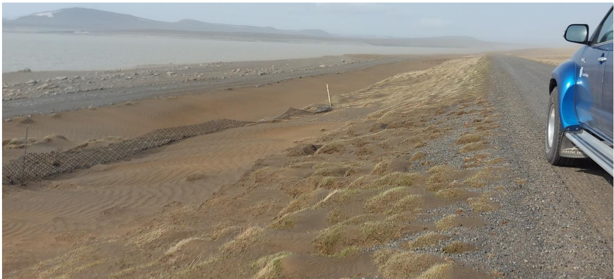
Mynd 10. Fullar sandgildirur á Lindabungu og mikið af áfoksefni sem safnast hefur við fokgirðingu.
