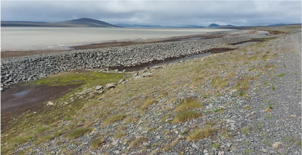
Mynd 25. Nýir grjótgarðar á Kofaöldu sem bæði mynda vörn gegn öldurofi og virka sem sandgildirur.
