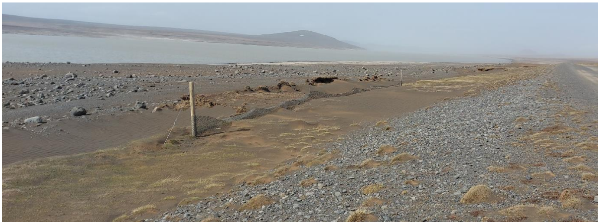
Mynd 3. Fokgirðingar sem safna efni en þyrfti að strekkja og lagfæra í sumar.
