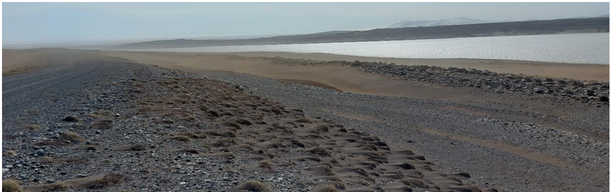
Mynd 2. Talsvert sandfok yfir Hálsveg þar sem sandgildirur eru orðnar nærri fullar og því hættar að nýtast sem skildi.
