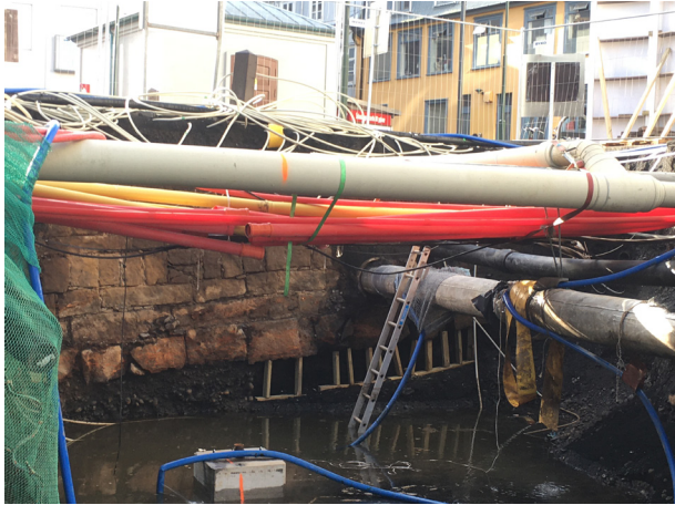
Mynd 25. Stundum var nokkur vatnselgur í skurðinum við vestari Steinbryggjuvegginn [011] svo að jarðvegur tók að skolast undan honum.
