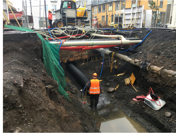
Mynd 26. Í upphafi var grafin hola undir vestari Steinbryggjuvegginn [011] til að koma lögnum undir hann en seinna var horfið frá þeirri aðgerð.
