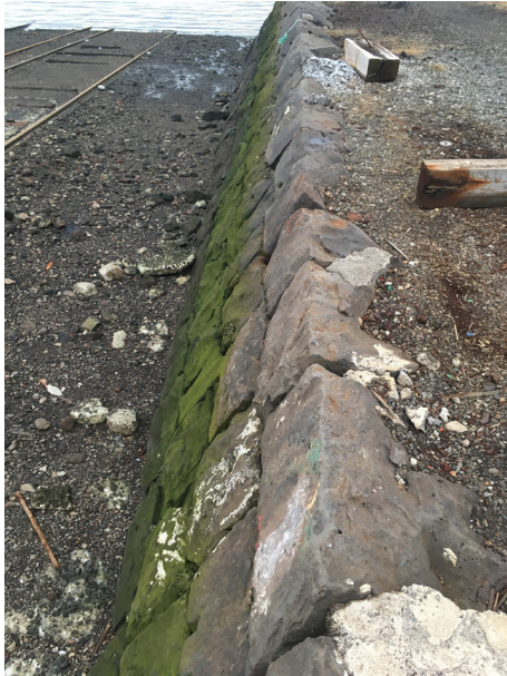
Mynd 41. Hér sést hvernig gengið hefur verið frá yfirborðinu á bólverkinum hjá Slippnum. Mun frágangurinn á bólverkinum á svæði A hafa verið sambærilegur.
