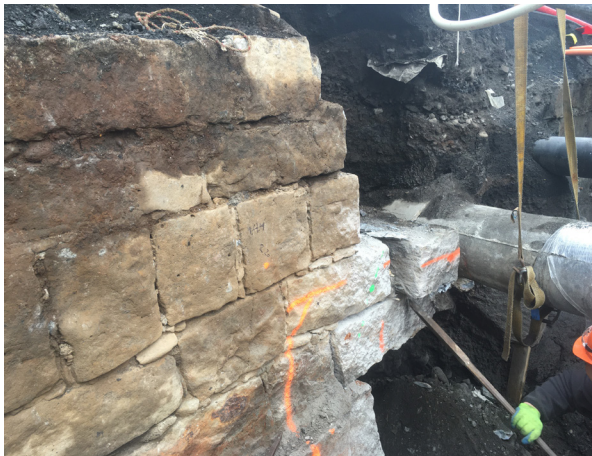
Mynd 27. Unnið að því að fjarlægja grjótt úr vestari Steinbryggjuveggnum [011].
