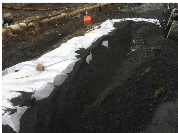
Mynd 11. Áður en jarðvegur var settur yfir hafnarkantinn aftur var hann hulið með jarðvegsdúk.
