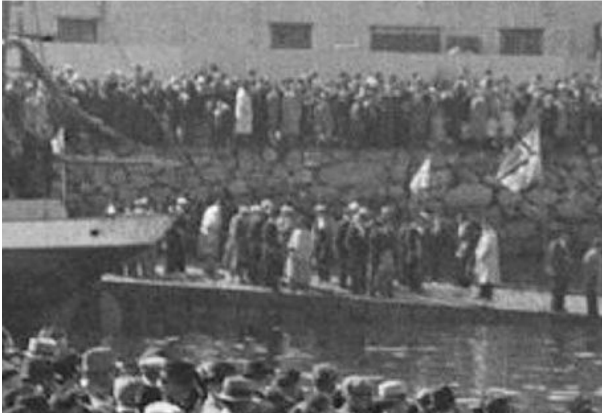
Mynd 12. Myndin var tekin 1938 í tilefni þess að Friðrik krónprins kom til Íslands. Ef rýnt er í myndina sést að sennilega hefur ekkert tilhoggið grjót verið efst á honum. Svipaðan frágang má enn sjá innan athafnarsvæðisins hjá Slippnum. Ljósmyndasafn Reykjavíkur
