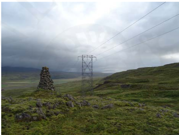
Prestavarða 014, horft til norðausturs.
