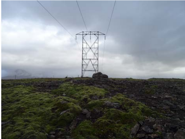
Landamerkjavarða 031, horft til norðurs.
