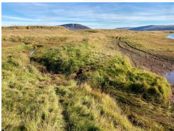
Upphlaðin brú 037_02, horft til suðausturs.
