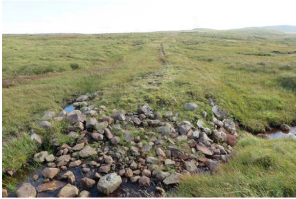
Upphlaðin mýrarbrú 001_05, horft til suðausturs.
