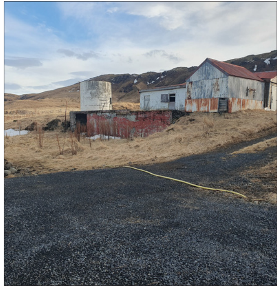
Mynd 7: Útihús 037, horft til norðausturs. Hleðslan er hægra megin við turninn.
