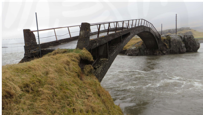
Brú 038 yfir Hamarsá, horft til NNV.
